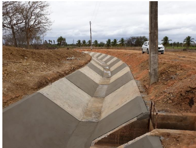
Figura 25 - Trecho do canal irrigado com técnica de concretagem alternada.
