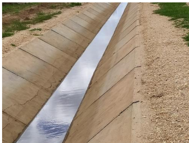
Figura 27 - Trincas localizadas nos canais de irrigação do sistema Cotinguiba-Pindoba.
