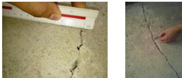
Figura 10 - Rachaduras causadas por solo expansivo no contrapiso de uma edificação.
