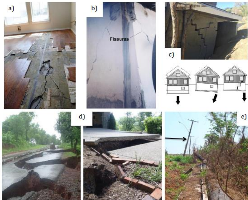
Figura 9 - Danos recorrentes nas estruturas causados pelos solos expansivos.
