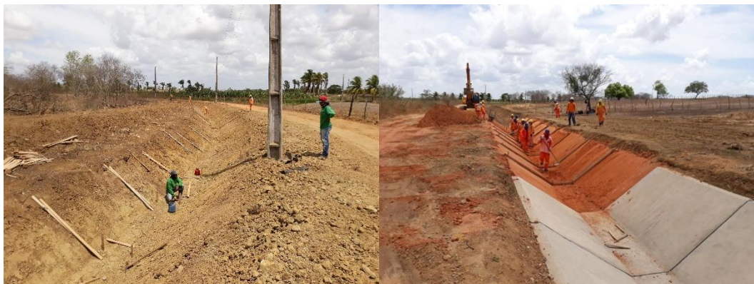
Figura 24 - Preparação do terreno e execução dos canais de irrigação.
