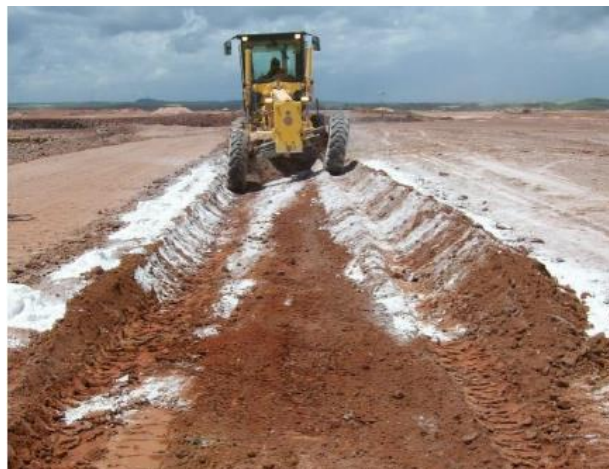
Figura 15 - Aplicação de cal em solo para estabilização.
