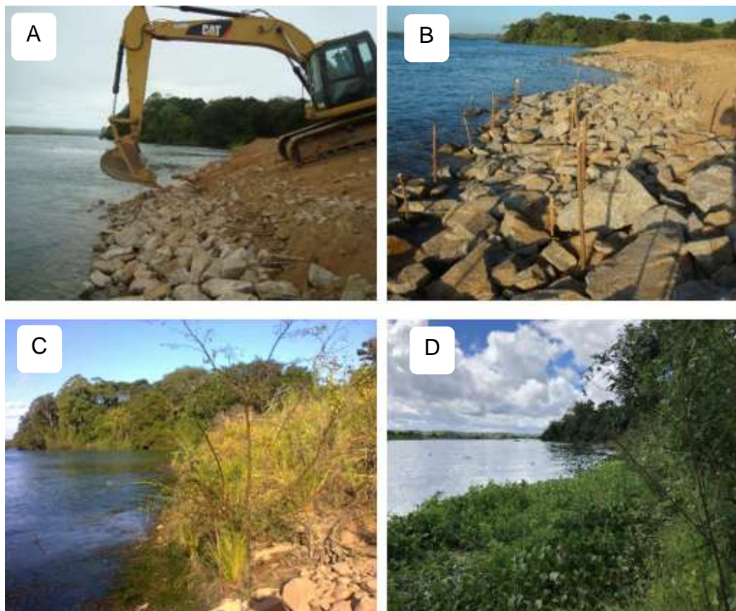
Figura 2- Evolução da implementação do enrocamento vegetado de 2011 a 2019. A – Processo de adição de rochas na base do talude. B – Fixação de estacas vivas de sabiá
