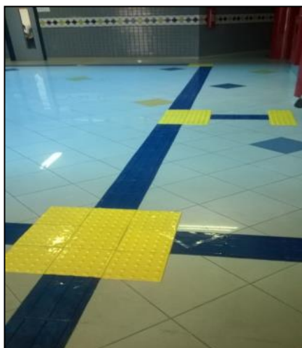
Figura 6 – Piso tátil no Bloco 1
