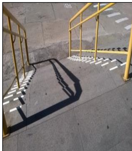
Figura 5 – Corrimão com guarda corpo
