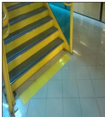
Figura 7 – Piso tátil no início e término de uma escada
