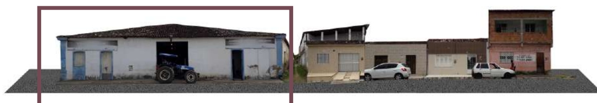
Edificação s/n (Ver inventário - Ficha 12)
