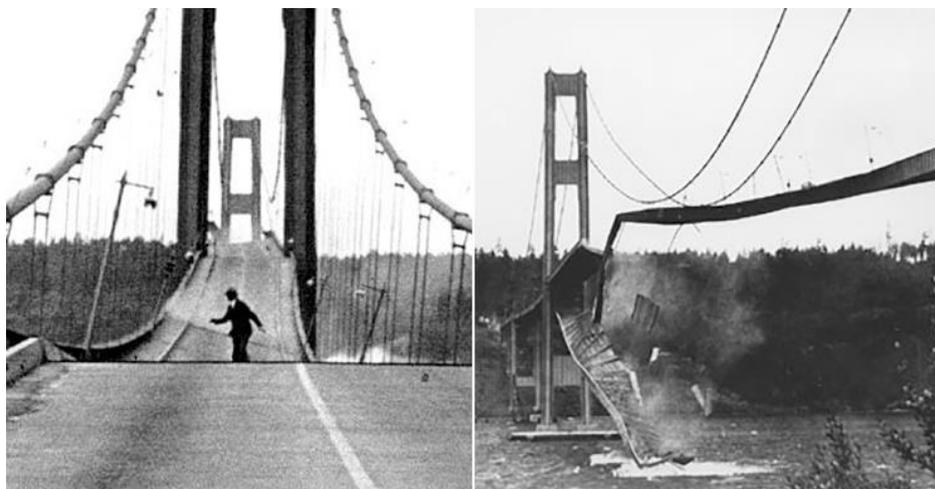
Figura 16 – Colapso da ponte Tacoma Narrows
