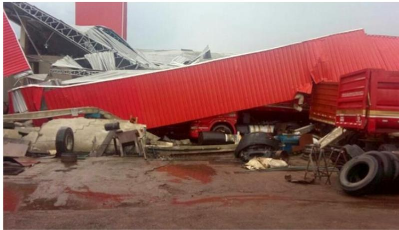
Figura 1 – Colapso de estrutura metálica após a passagem de vendaval
