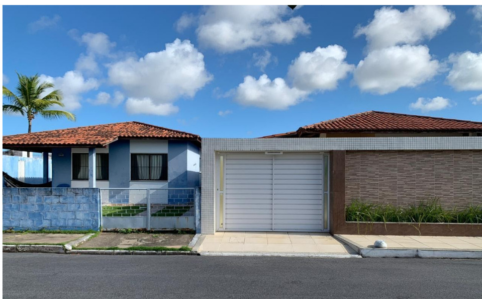
Figura 31: Casa padrão da construtora (esquerda) e uma que passou por reformas (direita).
