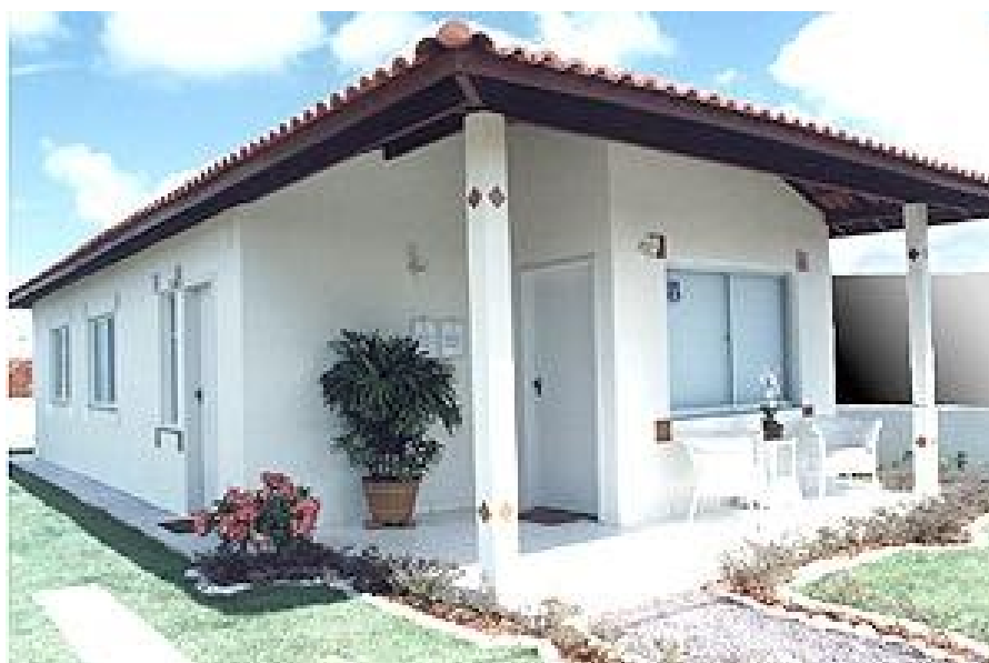
Figura 28: Casa térrea padrão da construtora.
