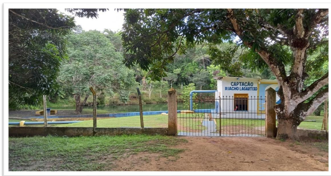
Imagem 17. Estação de captação de água do rio Lagartixo Fotografia do autor (abril/2021).
