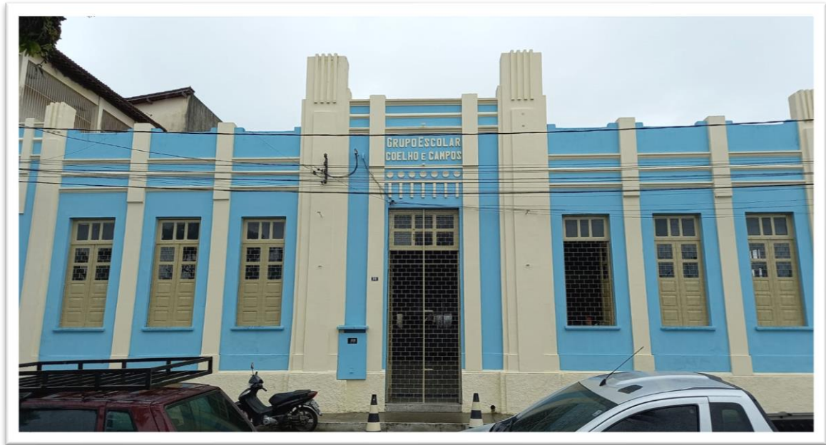
Imagem 7. Colégio Estadual Coelho e Campos, situado na Praça Manoel Cardoso Souza Fotografia do autor (julho/2021).
