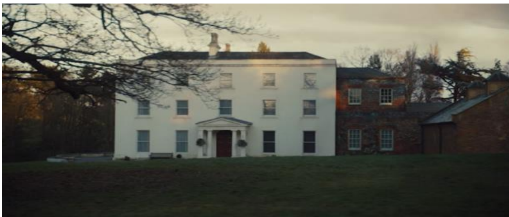
Figura 5 - Fachada do convento de Sean Ross: lavanderia anexada ao lado (00:24:02).
