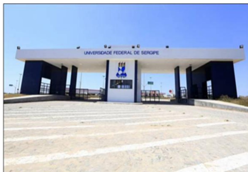
Figura 4: Vista da entrada do Campus Universitário Professor Antônio Garcia Filho.
