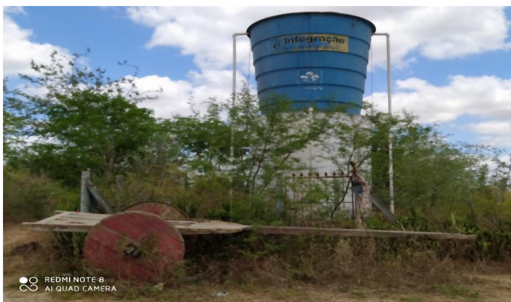
Figura 35: Poço artesiano no povoado Santa Rosa do Ermírio - Poço Redondo-Se, 2019
