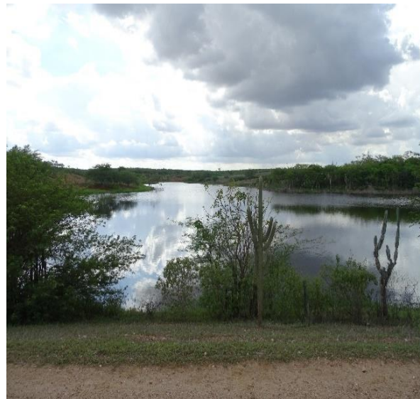
Figura 12: Barragem do Augustinho – Povoado Augustinho – Nossa Senhora da Glória-Se, 2019
