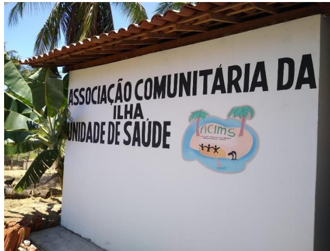
Figura 33: Foto da unidade de saúde construída na ilha.
