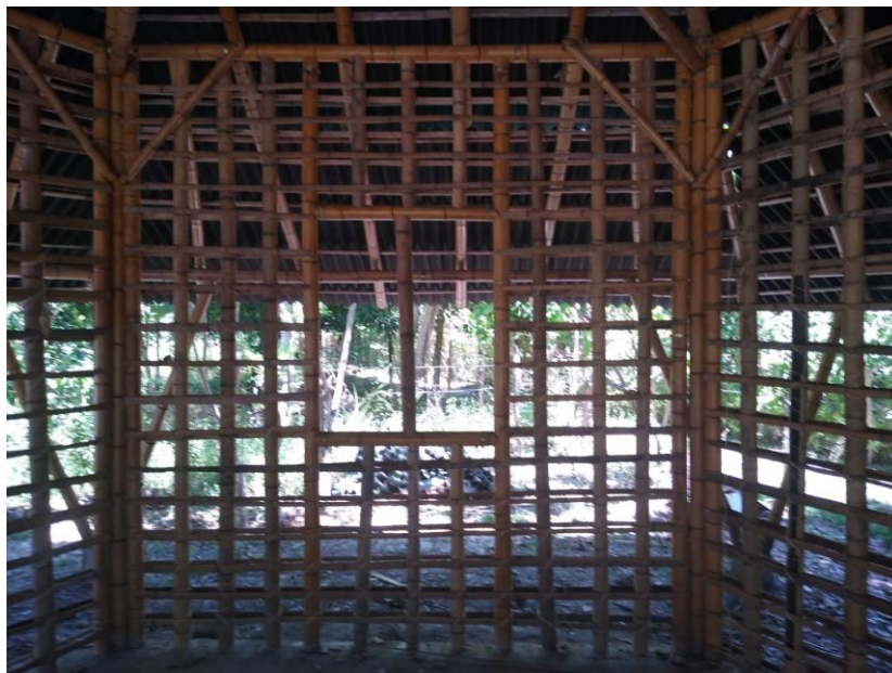
Figura 41: Foto detalhe parede com abertura da janela de bambu do módulo.
