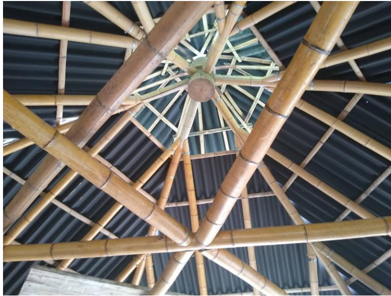
Figura 40: Foto detalhe cobertura de bambu do módulo.
