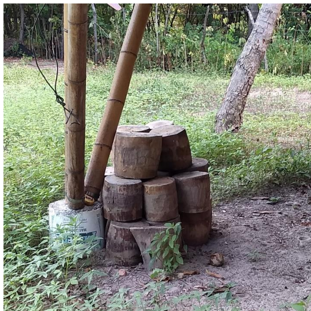
Figura 38: Foto detalhe do pilar de bambu do módulo.
