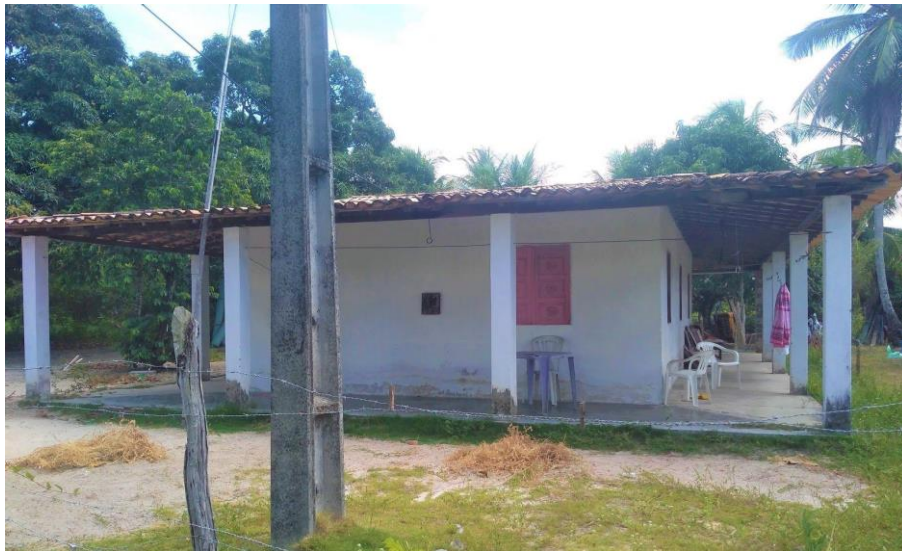
Figura 20: Residência de alvenaria com alpendres, nos modos de construção da ilha.
