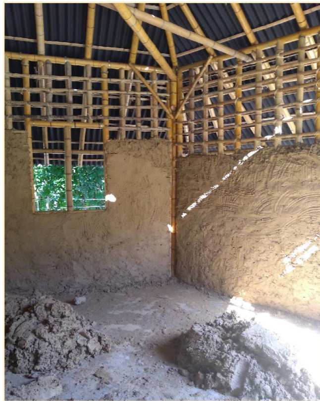
Figura 49: Área interna do módulo de bambu do camping -Ilha Mem de Sá, durante o barramento das paredes.
