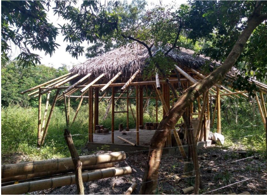
Figura 37: Foto ampliação do telhado e estrutura de bambu.
