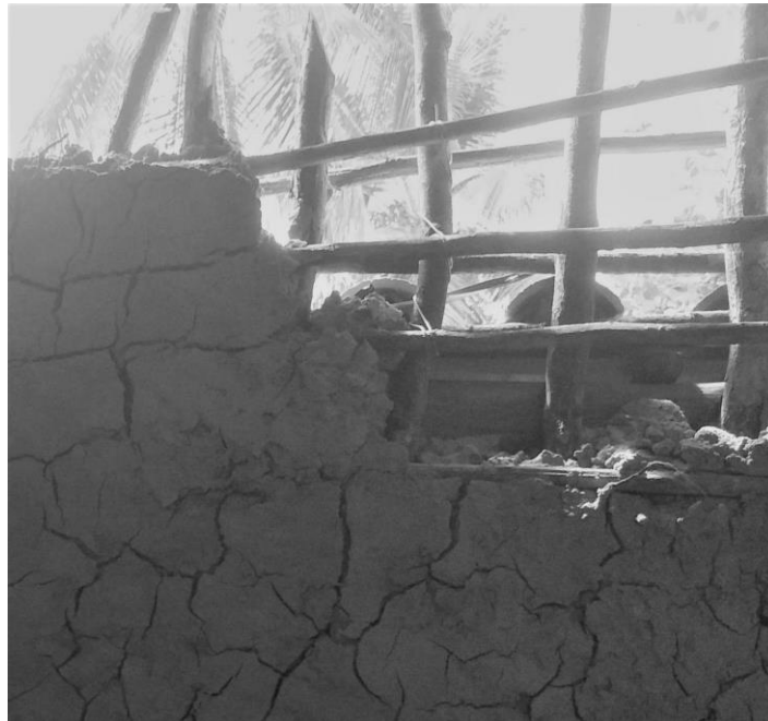
Figura 12: Detalhe construtivo do Engenho do Seu Salvador, feito pelo mesmo nas técnicas tradicionais de taipa de mão da ilha.
