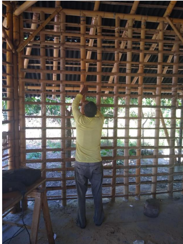
Figura 39: Foto detalhe das paredes de bambu do módulo.
