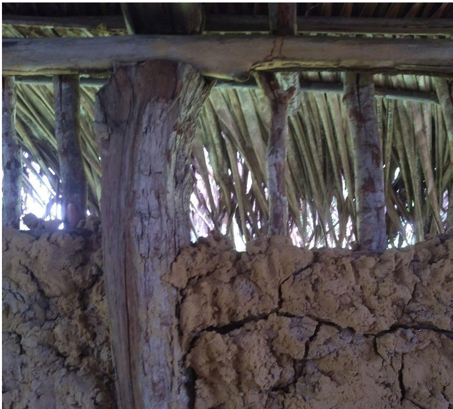
Figura 14: Detalhe construtivo do Engenho do Seu Salvador, feito pelo mesmo nas técnicas tradicionais de taipa de mão da ilha.
