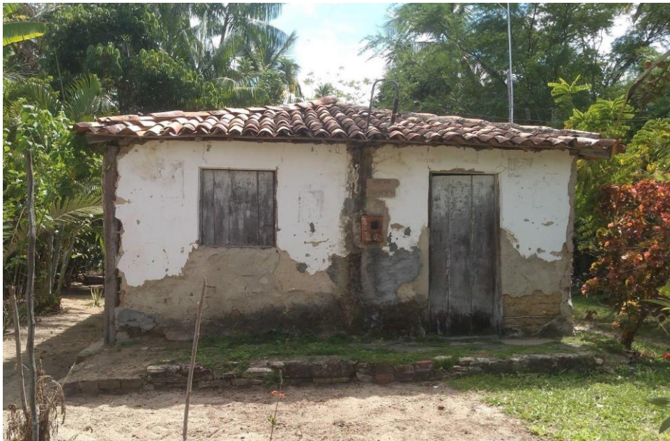
Figura 28: Casa na Ilha Mem de Sá feita em taipa com reboco de cimento aplicado sobre as paredes externas.
