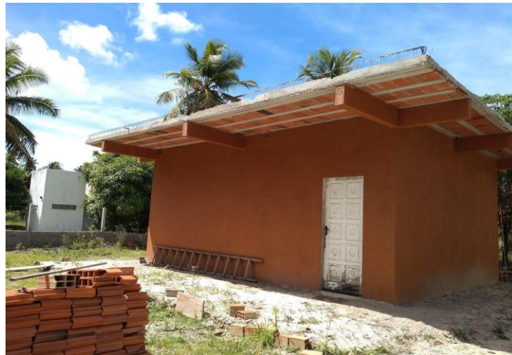
Figura 22: Residência em construção na Ilha com cobertura de laje.
