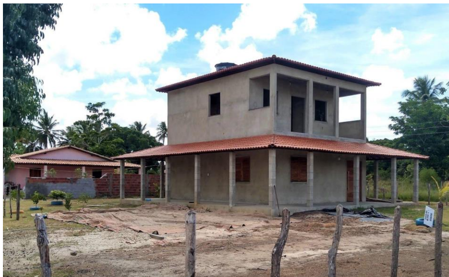
Figura 24: Residência de pavimento duplo, em construção na Ilha Mem de Sá.
