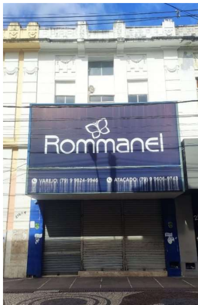
Figura 71 – Edifício 1 em análise.
