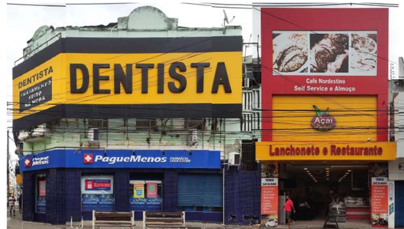
Figuras 89 – Edifícios Pague Menos (B1) e Lanchonete e Restaurante (B2)
