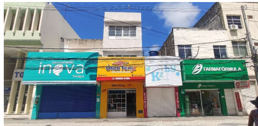
Figura 86 – Edifícios C7 a C10
