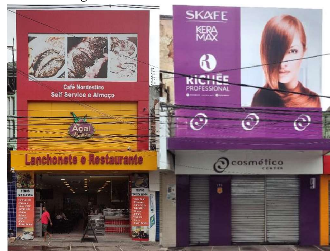
Figuras 104 e 105 – Edifícios B2 e B7
