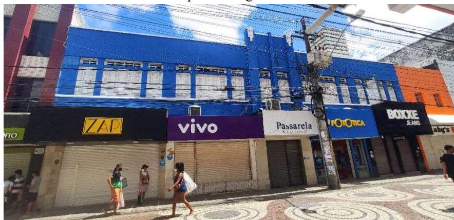
Figura 65 – Edifício histórico com o pavimento térreo fragmentado em pequenas partes desiguais
