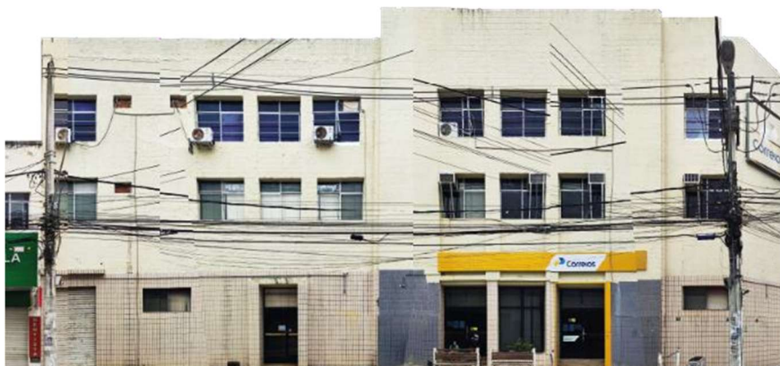
Figura 83 – Edificação dos Correios (C11)
