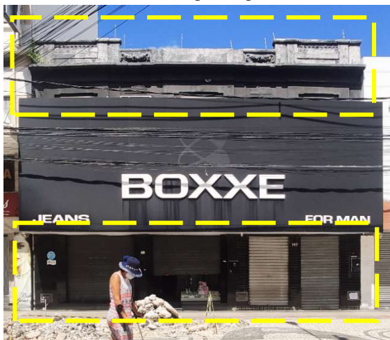
Figuras 40 – Edificação que demonstra o emprego de estratégias publicitárias apelativas nas fachadas, a exemplo da pintura e do revestimento
