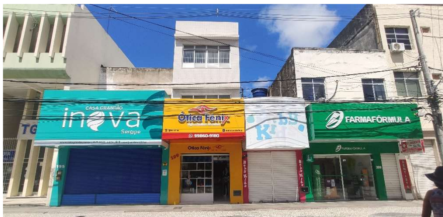
Figura 92 – Edifícios C7 a C10
