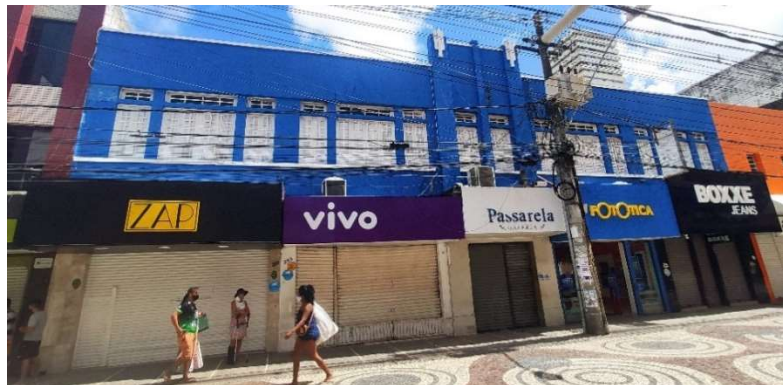
Figura 75 – Edifício 2 em análise.
