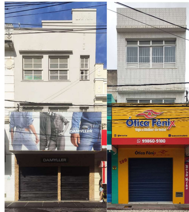
Figuras 97 e 98 – Edifícios A6 e C8
