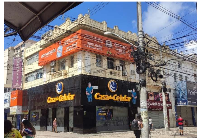
Figura 80 – Edificação da Casa do Celular (A1)
