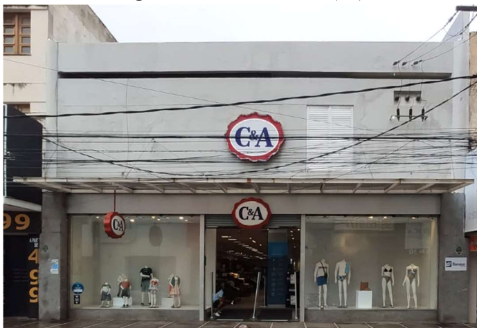
Figura 106 – Edifício C&A (B5)
