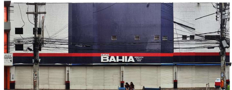
Figura 82 – Edificação da loja Casas Bahia (B11)
