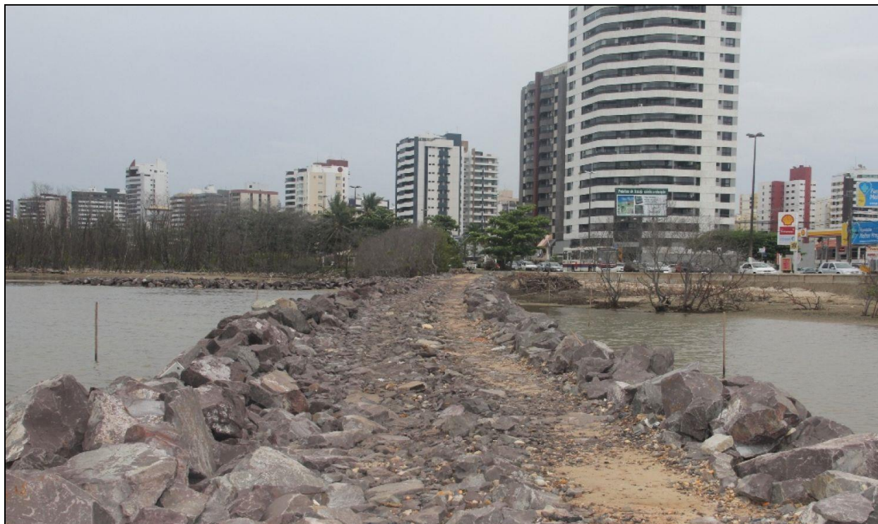
Figura 10 - Obras de contenção no bairro Treze de julho.
