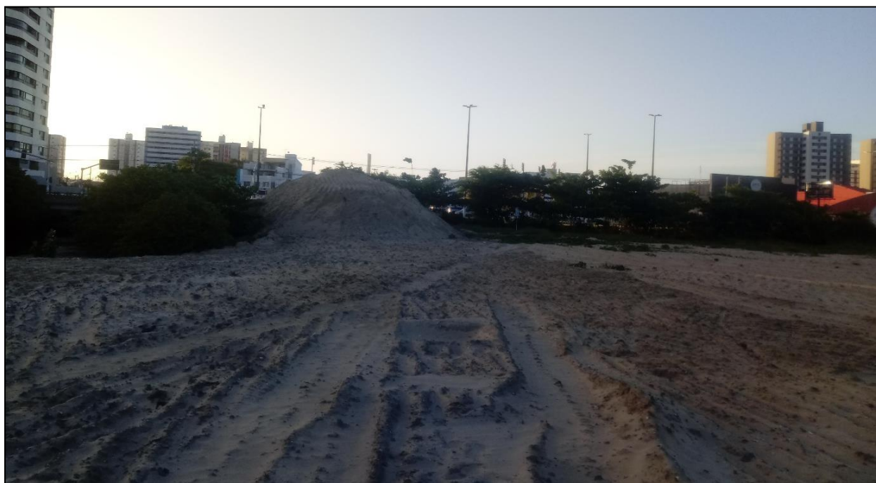
Figura 11 – Aterro na obra de contenção da maré na Orla do Bairro Treze de Julho.
