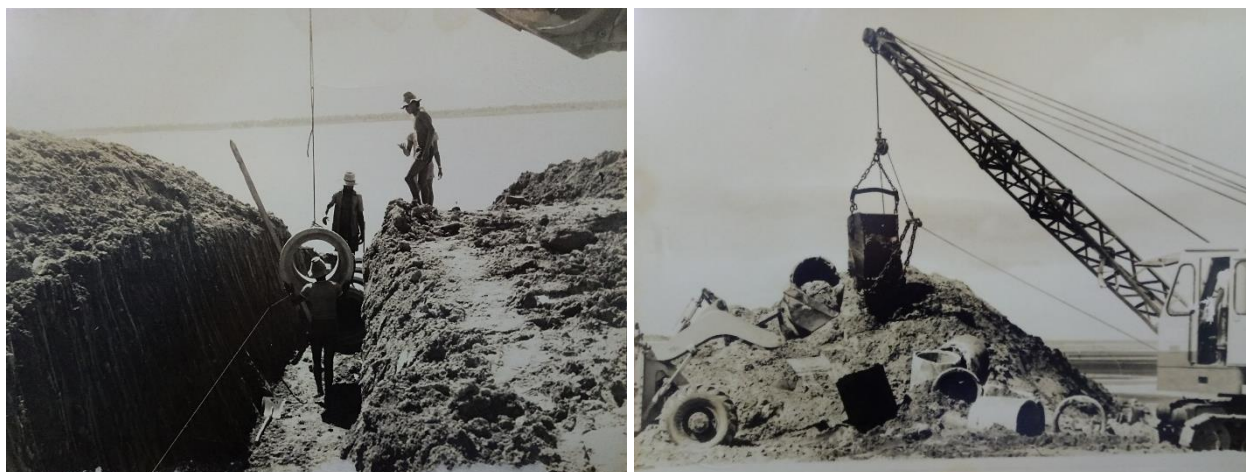
Figura 04 - Obras de ampliação de emissário conectado ao estuário do Rio Sergipe (1972).
