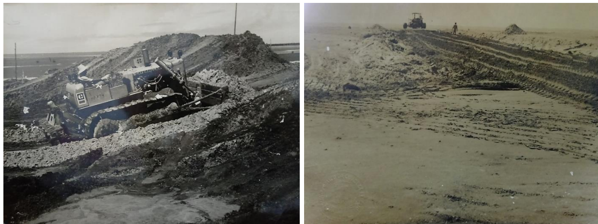
Figura 02 - Obras de aterro no bairro Treze de Julho (sem data).
