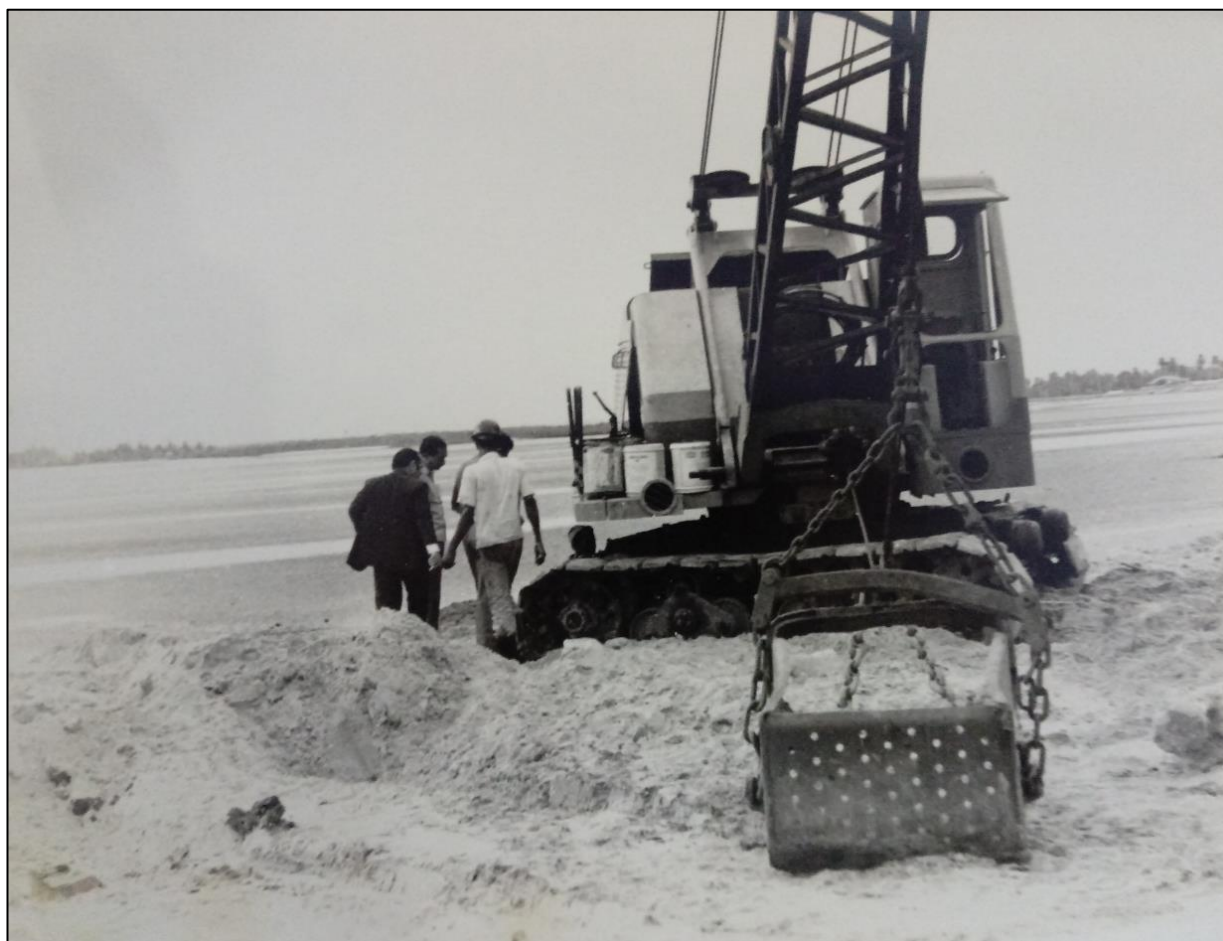
Figura 03 - Obras no bairro Treze de Julho, então Praia Formosa.
