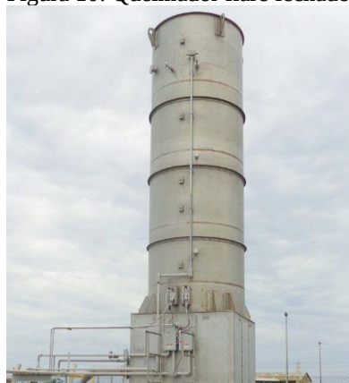
Figura 10: Queimador flare fechado.
