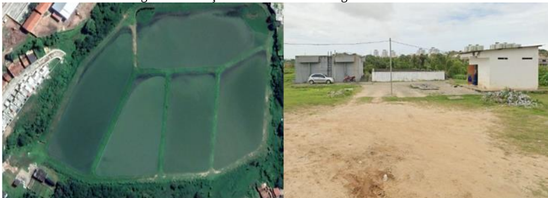
Figura 15: Estação de Tratamento de Esgoto Rosa Elze.
