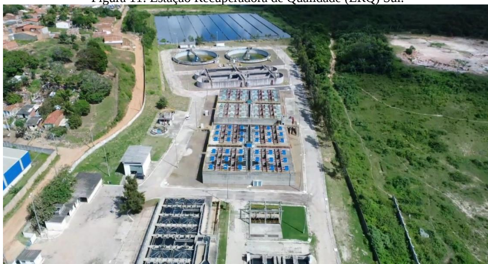
Figura 11: Estação Recuperadora de Qualidade (ERQ) Sul.
