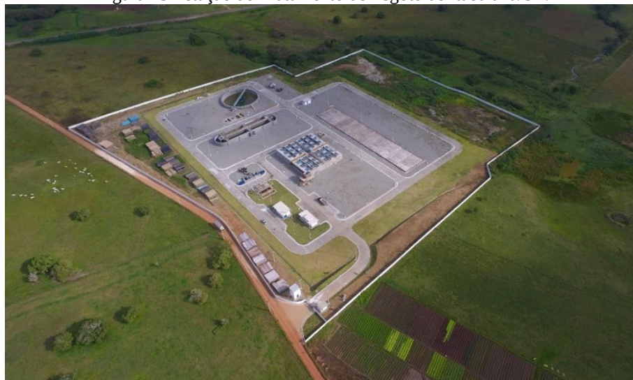
Figura 13 Estação de Tratamento de Esgoto de Itabaiana/SE.
