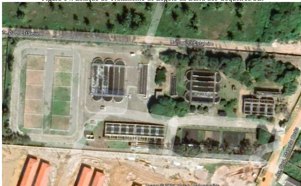
Figura 14: Estação de Tratamento de Esgoto da Barra dos Coqueiros/SE.
