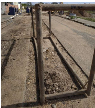
a) Quadro metálico.
