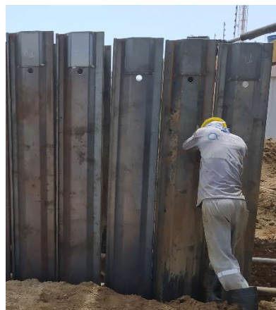
b) Pranchas metálicas.
