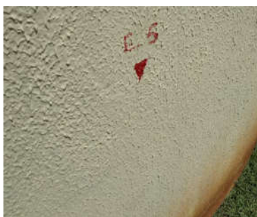
Figura 10 - Demarcação de estaca utilizada para assentamento de tubulação
