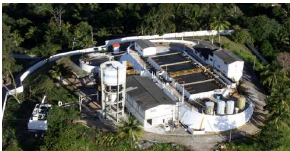
Figura 3 – Visão superior da Estação de Tratamento de Água Cabrita
