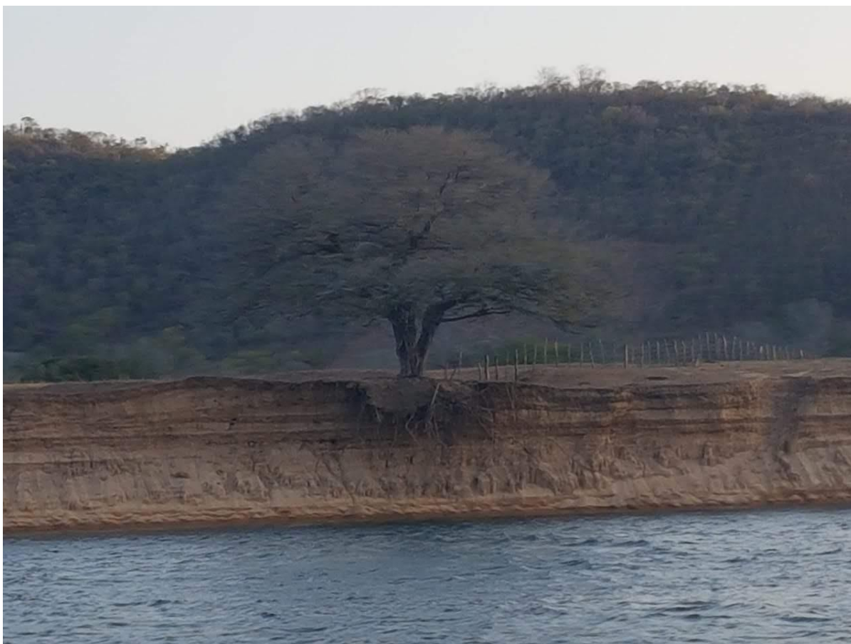
Figura 16: Processo erosivo às margens do rio São Francisco, nas proximidades de Ilha das Flores/SE.
