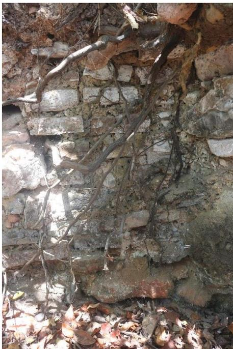
**Figura 290** - Detalhe do perfil construtivo de um forno de cal nos arredores da casa do Padre Vigário Tenório. Fonte: Acervo pessoal. Foto de Josué Lopes. 2020. (9135907/295879)
