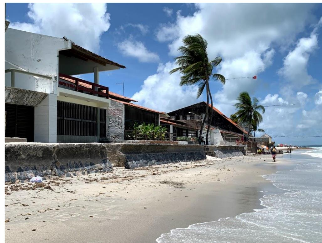
**Figura 27** - Estruturas de contenção foram realizadas para conter a força da água. Fonte: Acervo pessoal. Foto de Josué Lopes. 2020.
