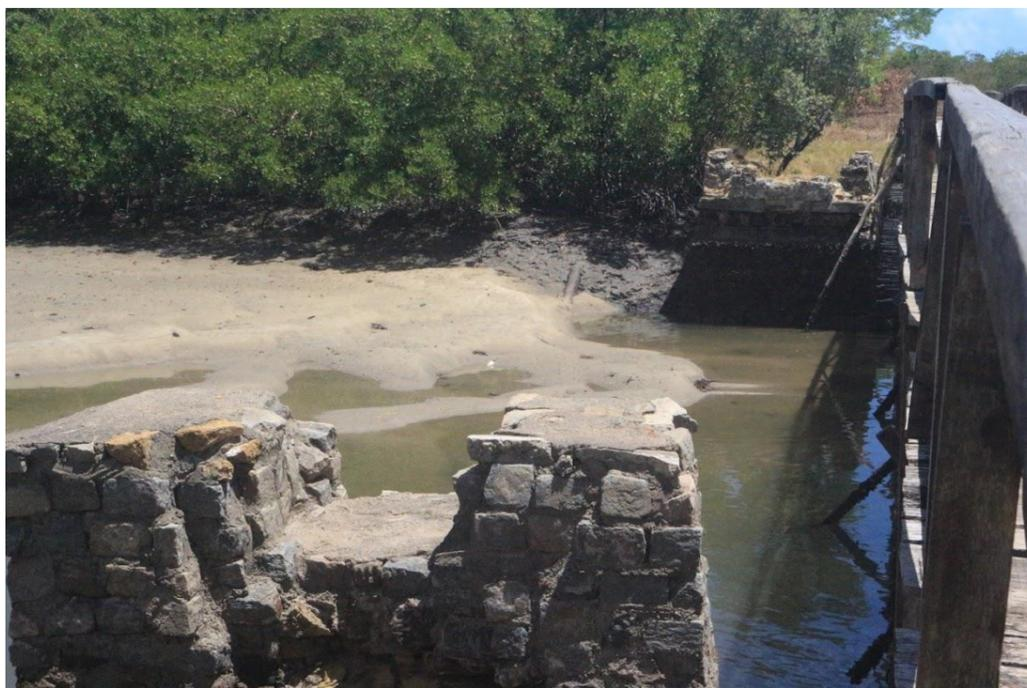
**Figura 264** - Cabeças da 'ponte dos holandeses'. Estruturas superiores correspondem a construções recentes. Fonte: Acervo pessoal. Foto de Cecília Barthel. 2020. (9136095/ 295287)
