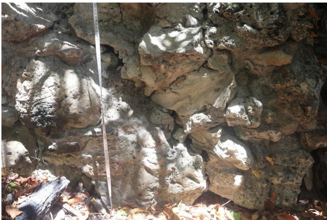
**Figura 291** - Perfil construtivo dos fornos de cal nos arredores da casa do Padre Vigário Tenório indica tijolos e pedaços de coral. Fonte: Acervo pessoal. Foto de Josué Lopes. 2020. (9135907/295879)
