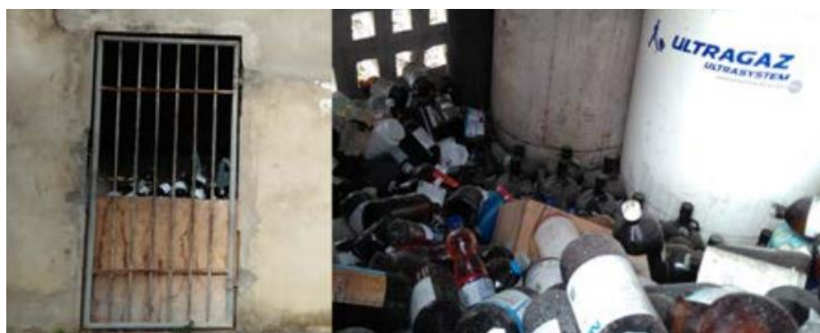
Figura 2 - Casa de gás antes da intervenção em 2018.
