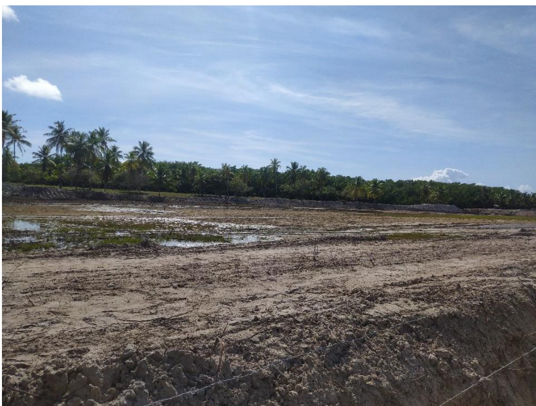
Figura 13: Construção de viveiros de camarão
