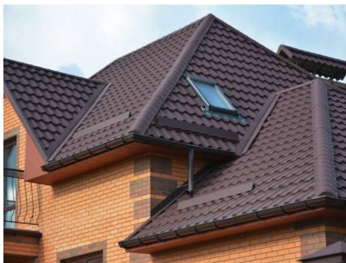
Figura 8 – Telhado com subdivisões em áreas menores.
