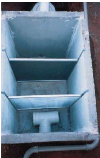
Figura 14 – Sistema de retenção de partículas sólidas.
