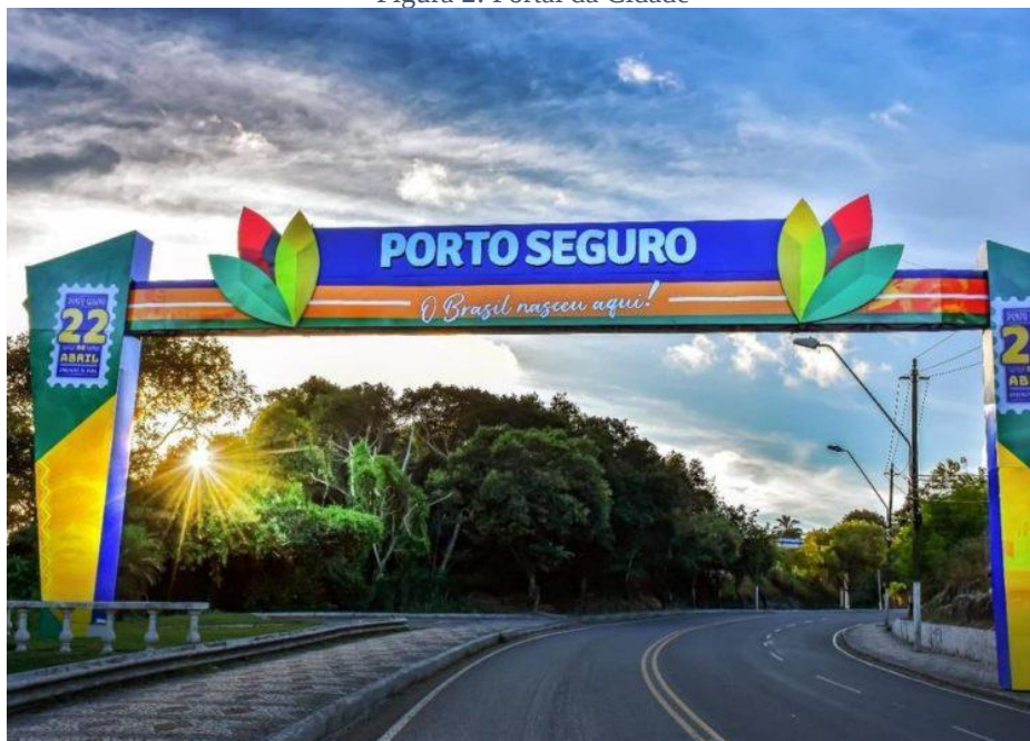
Figura 2: Portal da Cidade
