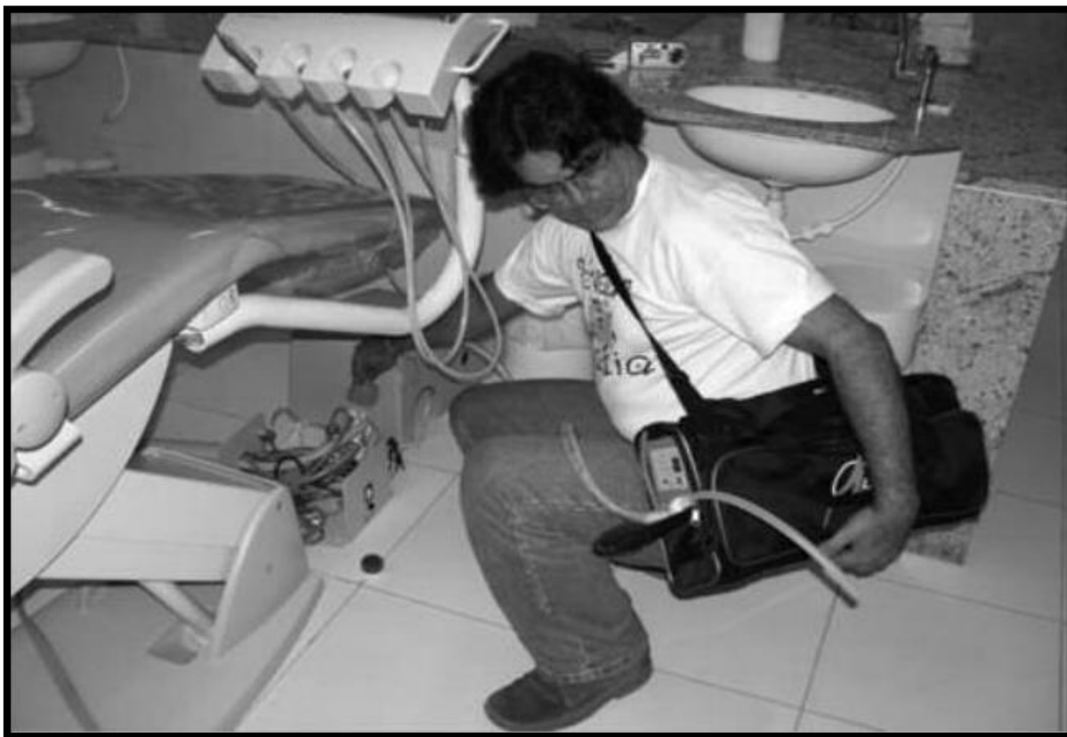
Figura 5- Inspeção do ar do fim da tubulação de dejetos da cuspideira de cadeira odontológica
