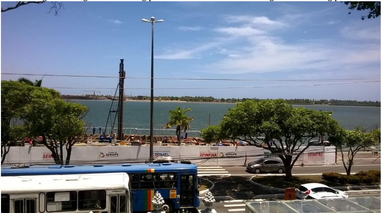
Figura 9: Largo da Gente Sergipana sendo construído sobre as águas do Rio Sergipe.
