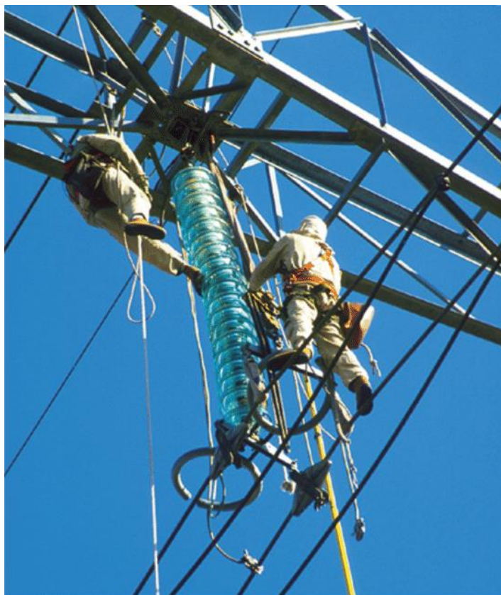
Figura 2 - Isoladores de vidro em linha de transmissão.
