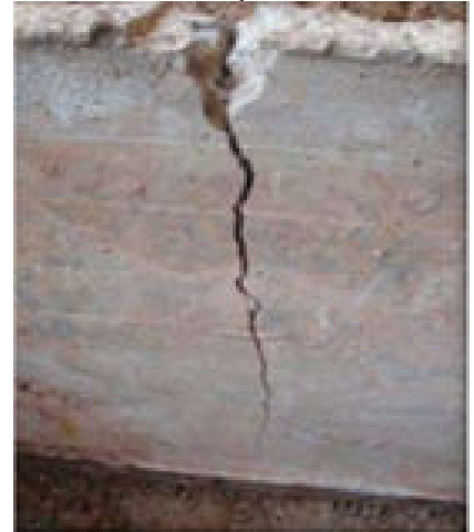
(c) Ruptura de viga baldrame, Santa Maria-RS. Fonte: Soares (2013).
