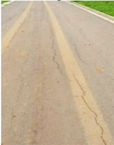
(a) Fissuras no pavimento da BR-364, Rio Branco-AC. Fonte: Barbosa, Guimarães e Marques (2021).
