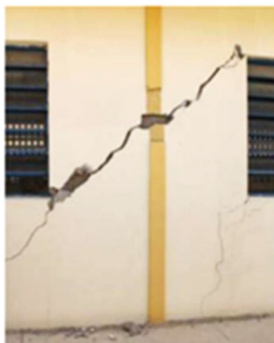
(e) Fissura e esmagamento de pilar, Sertão de Pernambuco. Fonte: Burgos et al. (2019).
