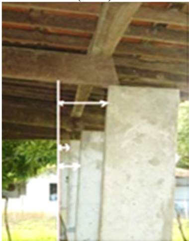
(d) Desaprumo de pilares, Santo Amaro-SE. Fonte: Cavalcante (2006).
