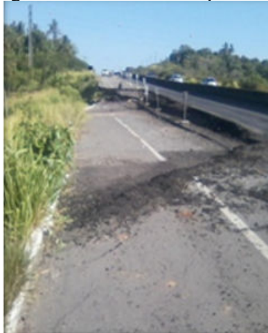
(b) Ruptura da BR-101, km 88, Nossa Senhor do Socorro-SE. Fonte: Cavalcante Jr. (2017).
