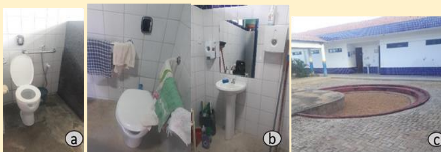
Figura 60: Banheiros e pátio: Creche Albuíno Bezerra Soares
