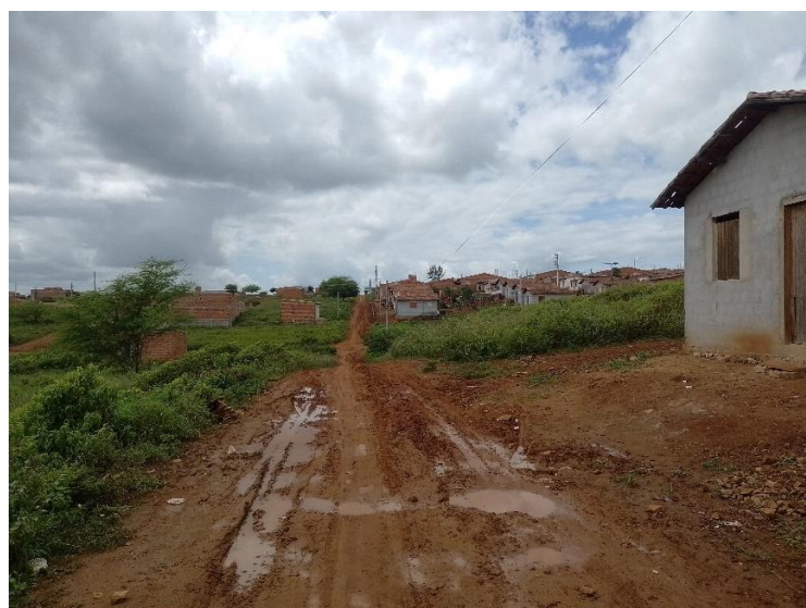
FIGURA 9: Ruas sem pavimentação no Conjunto Adelson Gomes II
