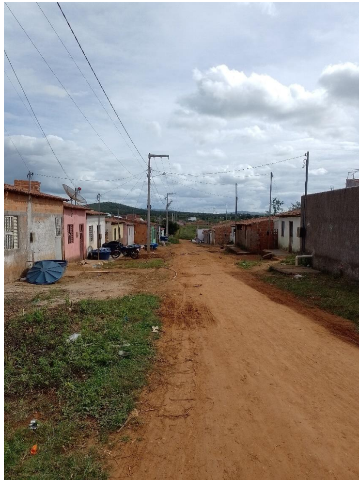
FIGURA 8: Ruas sem pavimentação no Conjunto Adelson Gomes II
