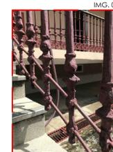
CORROSÃO METÁLICA - TRANSFORMAÇÃO DO MATERIAL POR INTERAÇÃO QUÍMICA OU ELETROQUÍMICA EM UM DETERMINADO MEIO EM FUNÇÃO DE SUA EXPOSIÇÃO, OCACIONADA POR CONTATO CONSTANTE COM UMIDADE.
