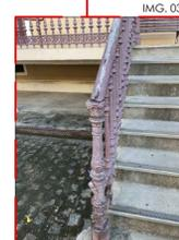
DESCASCAMENTO/ ESFOLIAÇÃO - DESTACAMENTO DE UMA OU MAIS CAMADAS DO SUBSTRATO SUPERFICIAL QUE SE MANIFESTA NORMALMENTE NA PINTURA OU NO REBOCO, MAS TAMBÉM PODE ACONTECER EM OUTROS MATERIAIS OCACIONADO POR PINTURA FEITA SOBRE SUPERFÍCIE ÚMIDA, EXCESSO DE REPINTURA SEM REMOÇÃO, UTILIZAÇÃO DE MATERIAIS INCOMPATÍVEIS.
