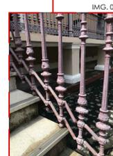
DESCASCAMENTO/ ESFOLIAÇÃO - DESTACAMENTO DE UMA OU MAIS CAMADAS DO SUBSTRATO SUPERFICIAL QUE SE MANIFESTA NORMALMENTE NA PINTURA OU NO REBOCO, MAS TAMBÉM PODE ACONTECER EM OUTROS MATERIAIS, OCACIONADO POR PINTURA FEITA SOBRE SUPERFÍCIE ÚMIDA, EXCESSO DE REFINITURA SEM REMOÇÃO, UTILIZAÇÃO DE MATERIAIS INCOMPATÍVEIS.
