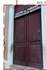
ALTERAÇÃO DE COR/ MANCHA/ PÁTINA - OCASIONADO POR PIGMENTOS INADEQUADOS, EXCESSO DE SAL NO MATERIAL, EXPOSIÇÃO EXCESSIVA AO SOL E/OU INTEMPÉRIES E PRESENÇA DE MATERIAIS ESTRANHOS (TINTAS, MICRO-ORGANISMOS, ETC).
