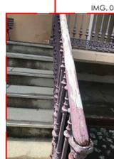
DESCASCAMENTO/ ESFOLIAÇÃO - DESTACAMENTO DE UMA OU MAIS CAMADAS DO SUBSTRATO SUPERFICIAL QUE SE MANIFESTA NORMALMENTE NA PINTURA OU NO REBOCO, MAS TAMBÉM PODE ACONTECER EM OUTROS MATERIAIS, OCACIONADO POR PINTURA FEITA SOBRE SUPERFÍCIE ÚMIDA, EXCESSO DE REFINITURA SEM REMOÇÃO, UTILIZAÇÃO DE MATERIAIS INCOMPATÍVEIS.
