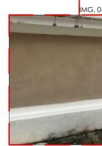
VESÍCULAS - PONTOS EM FORMA DE BOLHA QUE PROVOCAM DESCOLAMENTO DA PINTURA, OCASIONADA POR APLICAÇÃO DE PREMATURA DE TINTA IMPERMEÁVEL, INFILTRAÇÃO POR UMIDADE OU APLICAÇÃO DE TINTA INCOMPATÍVEL.
