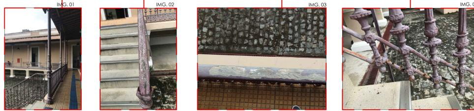
VARIAÇÃO DE COR DA SUPERFÍCIE DO MATERIAL - OCASIONADO POR PIGMENTOS INADEQUADOS, EXCESSO DE SAL NO MATERIAL, EXPOSIÇÃO EXCESSIVA AO SOL E/OU INTENSIDADE E PRESENÇA DE MATERIAIS ESTRANHOS (TINTAS, MICRO-ORGANISMOS, ETC).
