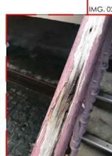
PERDA PARCIAL DA MADEIRA: OCACIONADA POR CHOQUES, REMOÇÃO OU PELA DEGRADAÇÃO DA PEÇA.
