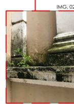
COLONIZAÇÃO BIOLÓGICA - PRESENÇA DE MICRO-ORGANISMOS OCASIONADA CONTATO COM UMIDADE EXCESSIVA, COLONIZAÇÃO POR BACTÉRIAS, FUNGOS, ALGAS, MUSGOS OU LÍQUENS E FALTA DE MANUTENÇÃO.
