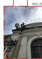
PRESENÇA DE VEGETAÇÃO NÃO PREVISTA OCASIONADA POR SEMEADURA DE AVES E MORCEGOS, EXCESSO DE UMIDADE E FALTA DE MANUTENÇÃO.
