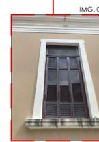
ALTERAÇÃO CROMÁTICA/ MANCHA/ PÁTINA - OCASIONADA POR PIGMENTOS INADEQUADOS, EXCESSO DE SAL NO MATERIAL, EXPOSIÇÃO EXCESSIVA AO SOL E/OU INTEMPÉRIAS E PRESENÇA DE MATERIAS ESTRANHOS (TINTAS, MICRO-ORGANISMOS, ETC).
