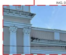
UMIDADE DESCENDENTE - UMIDADE ADIVINDA DA PARTE SUPERIOR DA EDIFICAÇÃO, OCASIONADA POR CHUVAS OU VAZAMENTOS DE RESERVATÓRIOS, PROBLEMAS NOS ESCOAMENTO DE ÁGUAS PLUVIAIS, INFILTRAÇÃO, MATERIAIS PERMEÁVEIS E FALTA DE MANUTENÇÃO.
