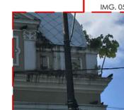
PRESENÇA DE VEGETAÇÃO NÃO PREVISTA - OCASIONADA POR SEMEADURA DE AVES E MORCEGOS, EXCESSO DE UMIDADE E FALTA DE MANUTENÇÃO.
