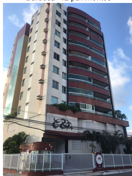
Figura 107: Edifício Imperattor, bairro Inácio Barbosa- 12 pavimentos
