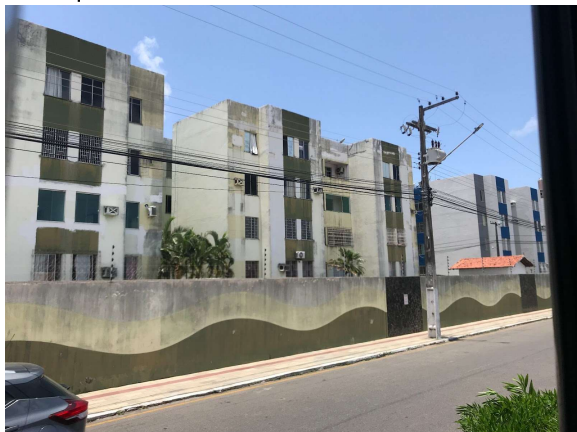
Figura 60: Condomínio Ilha Bella, bairro Grageru 4 pavimentos
