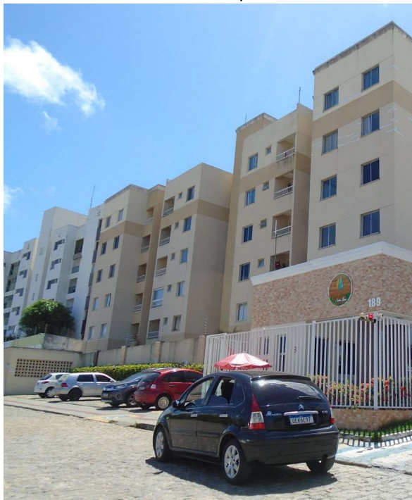
Figura 134: Condomínio Reserva Santa Lúcia, bairro Jabotiana - 6 pavimentos
