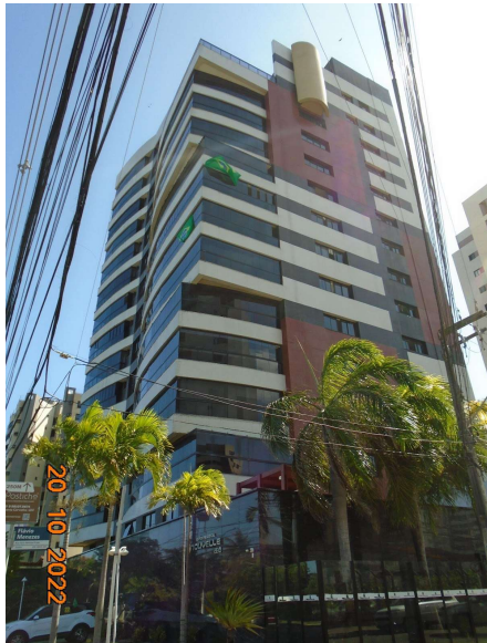
Figura 101: Edifício Nouvelle, bairro Jardins-14 pavimentos
