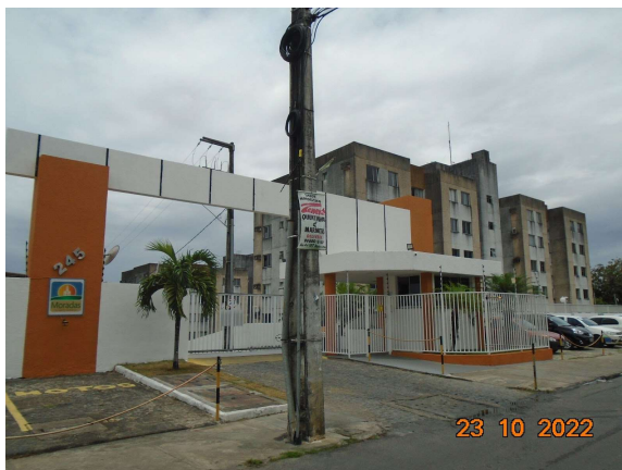
Figura 138: Moradas do Santo Antônio, bairro Santo Antônio-6 pavimentos
