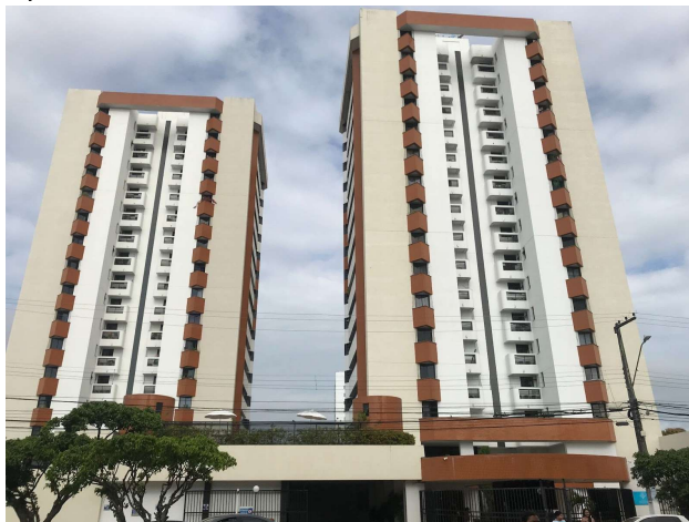
Figura 99: Condomínio Plaza São José, bairro São José 16 pavimentos
