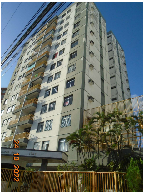
Figura 49: Condomínio Bahia Sol, bairro Suíça 12 pavimentos
