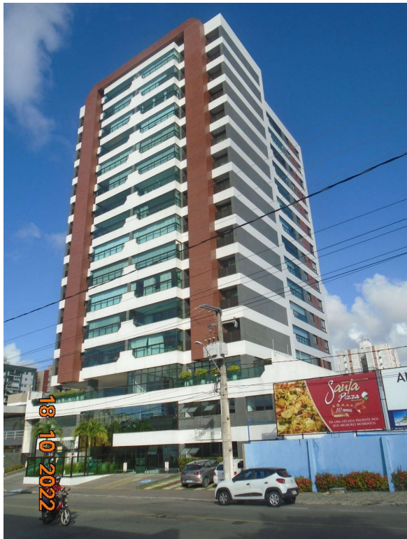
Figura 132: Edifício Praia Formosa, bairro Treze de Julho - 16 pavimentos
