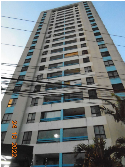
Figura 80: Condomínio Padre Arnóbio, bairro Luzia- 21 pavimentos
