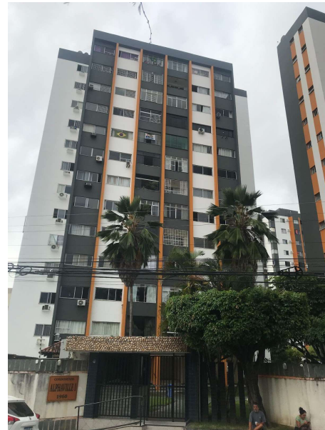
Figura 48: Condomínio Alphaville I, bairro Suíça 13 pavimentos
