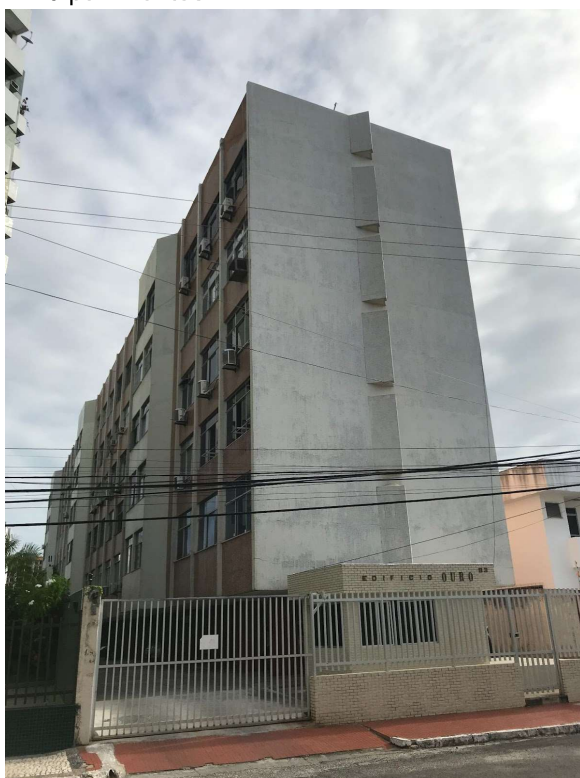
Figura 37: Edifício Ouro, bairro São José 6 pavimentos
