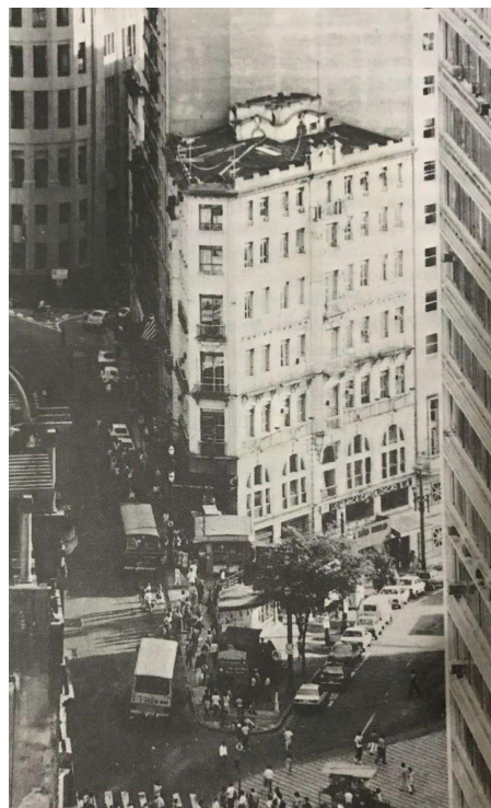
Figura 05: Edifício construído entre as ruas Libero Badaró e a Ladeira Dr. Falcão Júnior - São Paulo.
