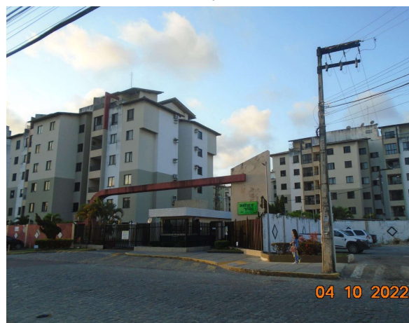
Figura 115: Natura Ville Eco Residence, bairro Jabotiana- 6 pavimentos
