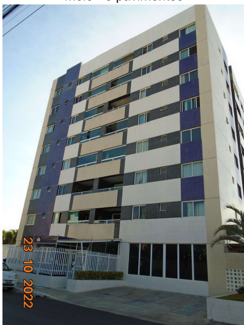
Figura 122: Blumar Residence, bairro Coroa do Meio - 8 pavimentos
