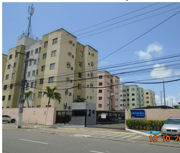
Figura 109: Residencial Vivendas Santo Antônio, bairro Santo Antônio-6 pavimentos
