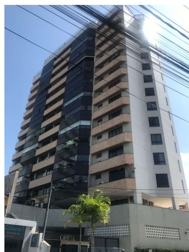
Figura 98: Edifício Crystal, bairro Treze de Julho
