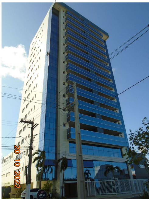
Figura 150: Mansão The View, bairro Jardins-16 pavimentos
