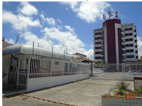
Figura 86: Condomínio Belleville Residence, bairro Ponto Novo- 8 pavimentos
