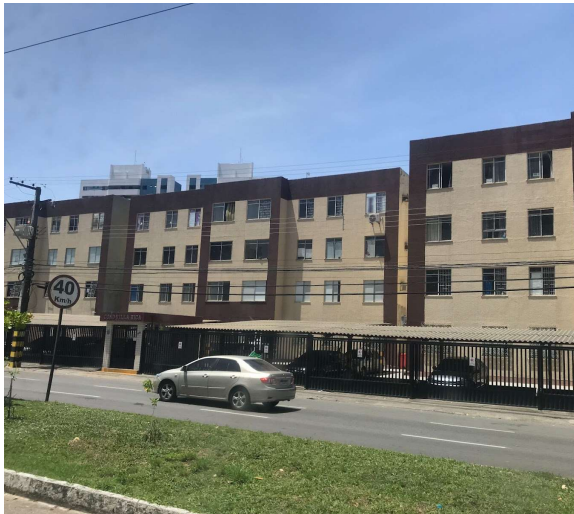
Figura 47: Condomínio Vila Rica, bairro Suíça 4 pavimentos
