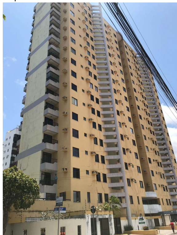
Figura 52: Edifício Sylvio Romero, bairro Treze de Julho 18 pavimentos
