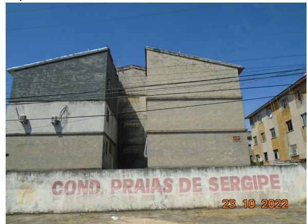
Figura 46: Condomínio Praias de Sergipe, bairro Farolândia 4 pavimentos
