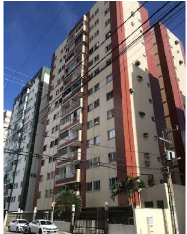
Figura 25:Edifício Saint Tropez (1980)
