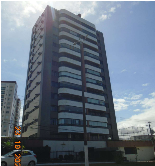
Figura 45: Condomínio Atlantic hills, bairro Farolândia 16 pavimentos
