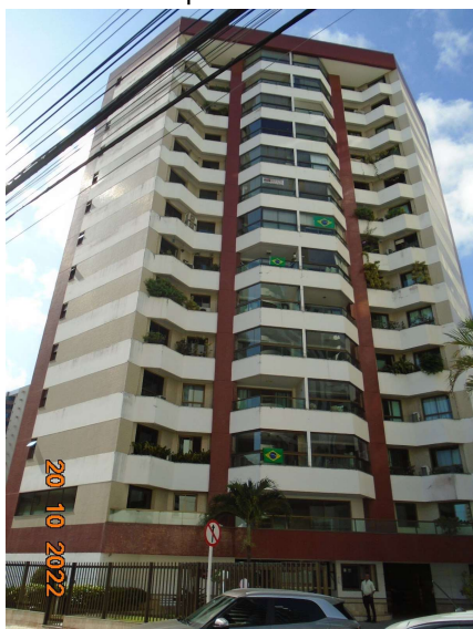
Figura 62: Edifício Gilberto Vila Nova, bairro Jardins 14 pavimentos
