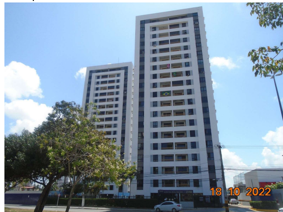
Figura 61: Condomínio Costa Dourada, bairro Luzia 19 pavimentos
