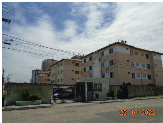
Figura 73: Residencial César Franco, bairro Farolândia 4 pavimentos
