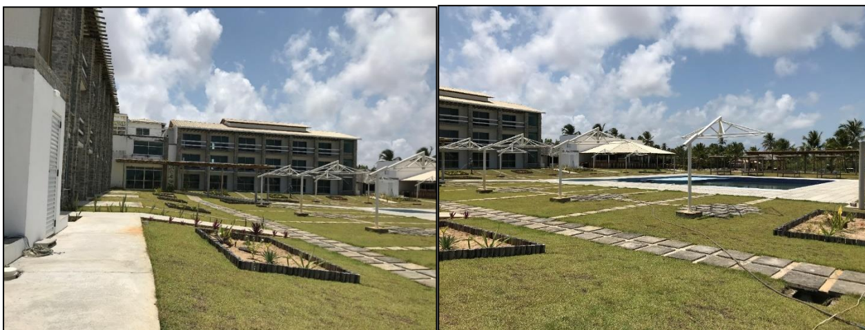
Figura 22: EcoPrivilege Hotel em fase final de instalação. (set/2021). Fonte: arquivo pessoal.
