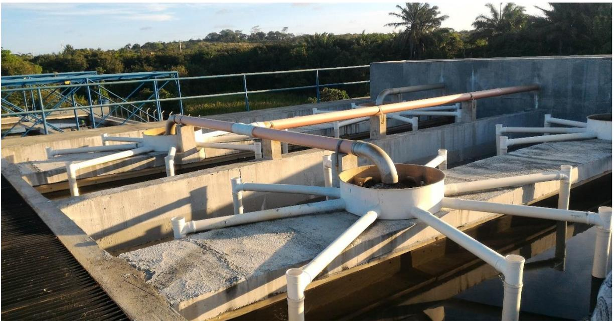
Figura 2 - Ponto de coleta do efluente em reator UASB de tratamento secundário na ETE da UFS.
