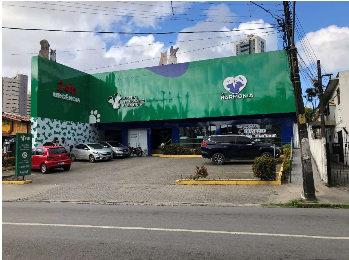
Figura 1: Fachada do hospital veterinário. Fonte: Arquivo pessoal (2022).
