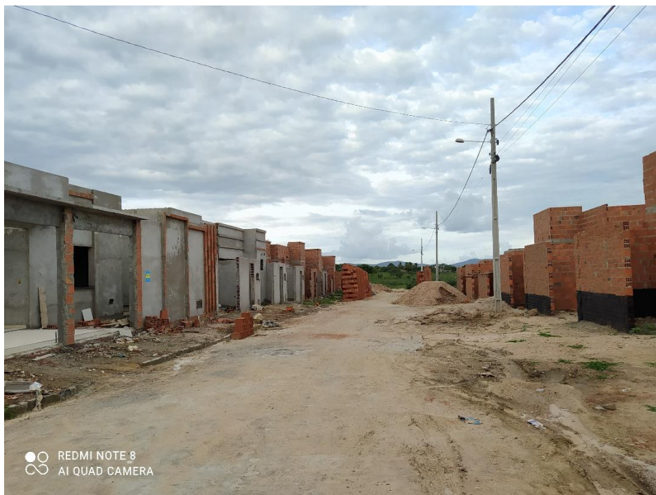
Figura 11: Casas em processo de construção no loteamento Santa Mônica II - 2022
