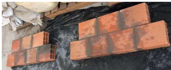
Figura 10: Protótipo da parede para ensaio da resistência de aderência à tração.
