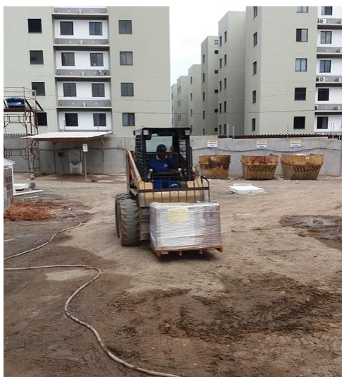
Figura 37: Utilização da mini-carregadeira para transporte de materiais.
