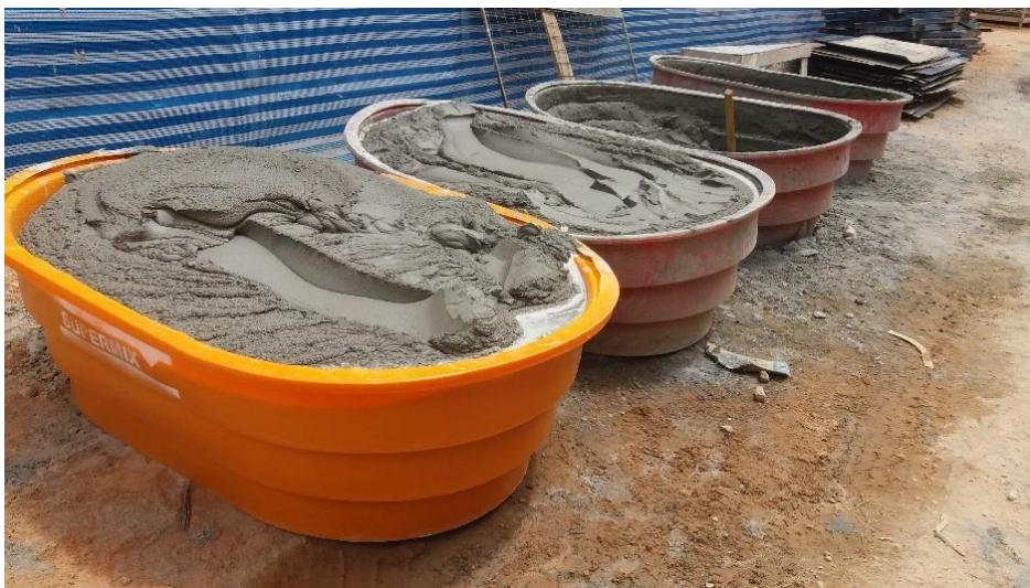
Figura 39: Utilização de argamassa usinada com aditivo retardador de pega.
