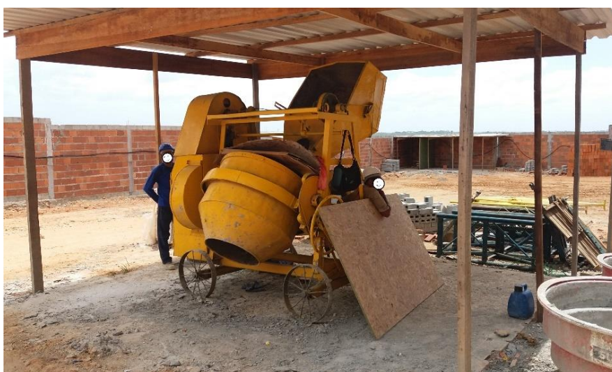
Figura 41: Betoneira com carregador de agregados.
