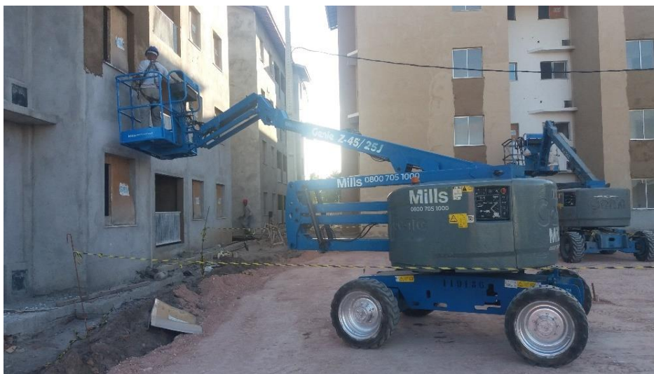
Figura 40: Utilização de manipulador para a pintura e aplicação de argamassa mineral na fachada.
