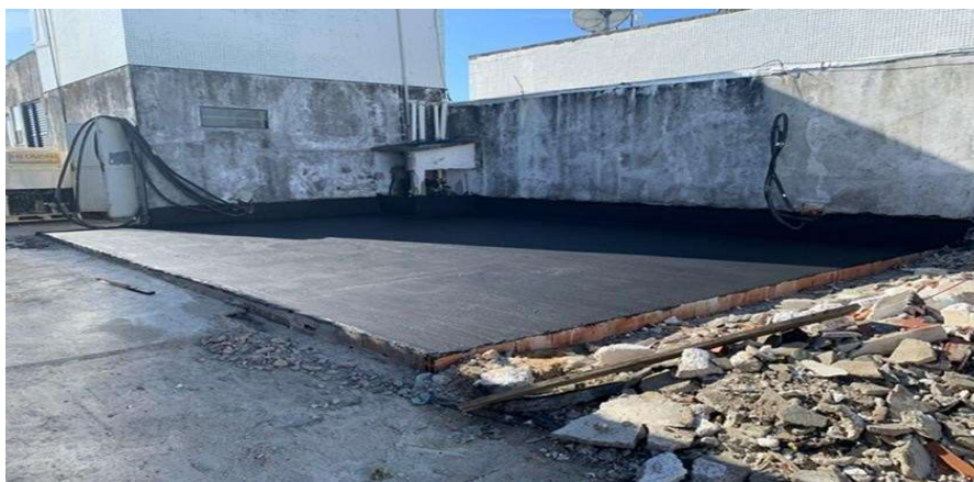
Figura 21 – Aplicação do primer
