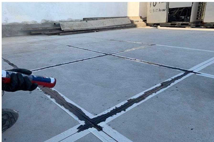
Figura 24 – Aplicação da manta asfáltica
