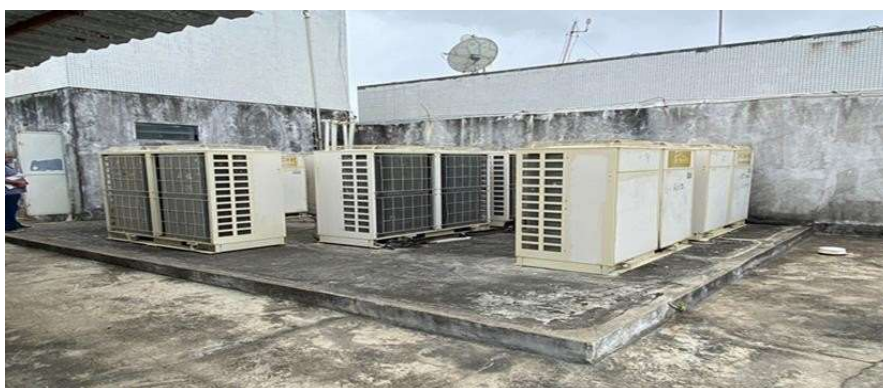
Figura 17 – Antes da demolição da proteção mecânica e remoção da manta asfáltica existente
