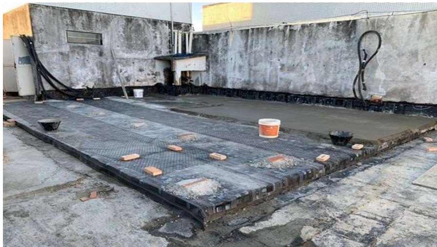
Figura 23 – Execução da proteção mecânica
