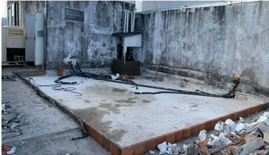
Figura 19 – Limpeza da área, após a remoção da manta e ampliação da área das condensadoras
