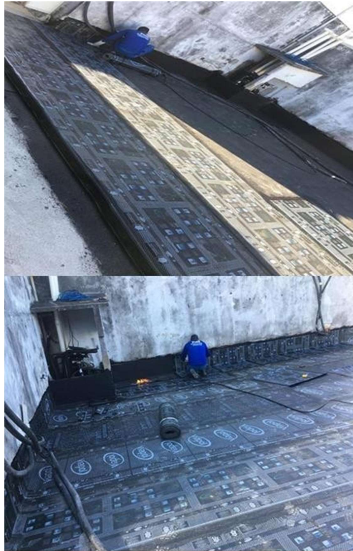
Figura 22 – Aplicação de manta asfáltica
