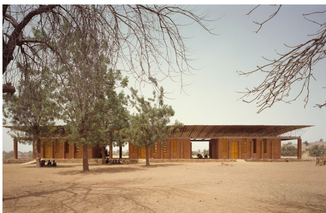
Figura 28 - Ampliação da Primary School in Gando
