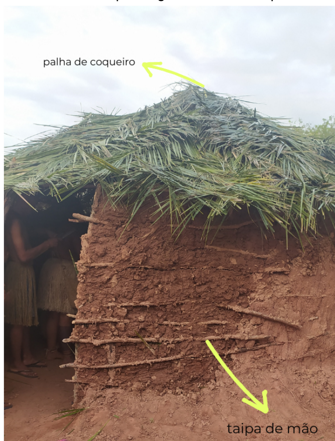
Figura 39 - Pequeno cômodo construído por indígenas Kaimbé, em taipa de mão e cobertura de palha .
