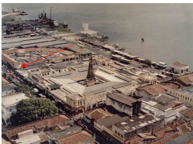
Figura 6 - Mercado de Aracaju nos anos 90: o crescimento desordenado (seta vermelha) trazia complicações para comerciantes, clientes e para a própria estrutura física do mercado. Foto: Lineu Lins, 1992.
