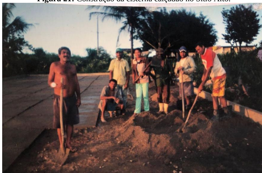
Figura 21: Construção da cisterna calçadão no Sítio Alto.
