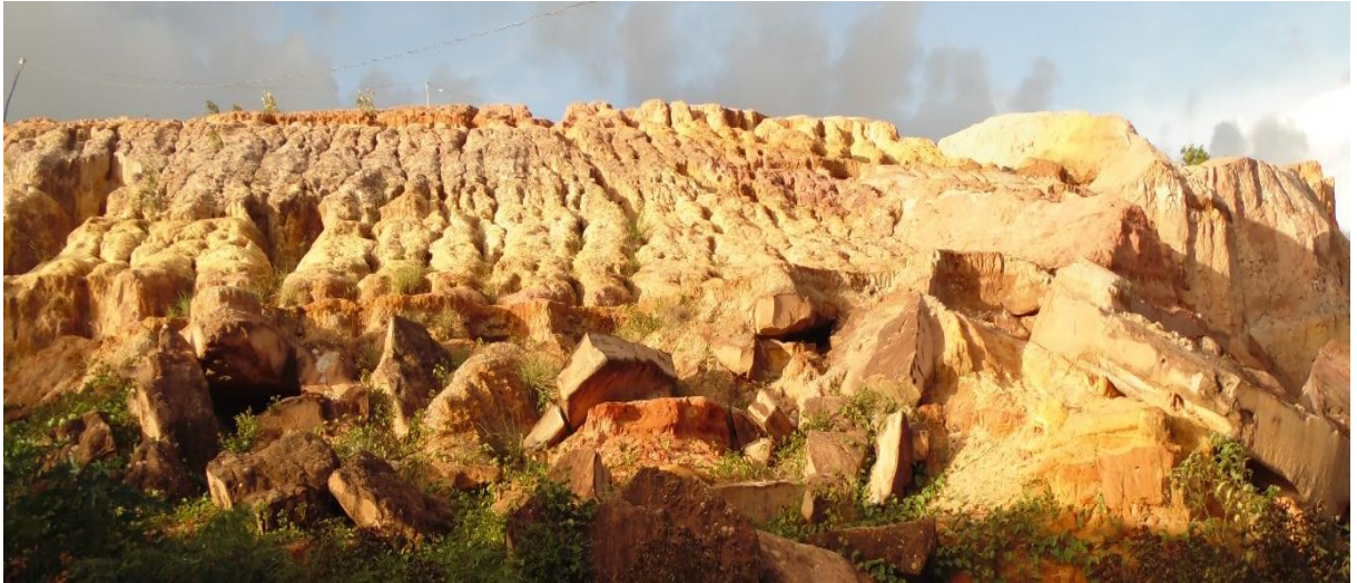
Figura 66: Formação de ravinas nos terços superior e médio do Morro do Avião, denunciando processo erosivo mais crítico. Na extensão da encosta, observa-se o dismantelamento de blocos de arenito consolidado acumulados na base, Bairro Santa Maria.
