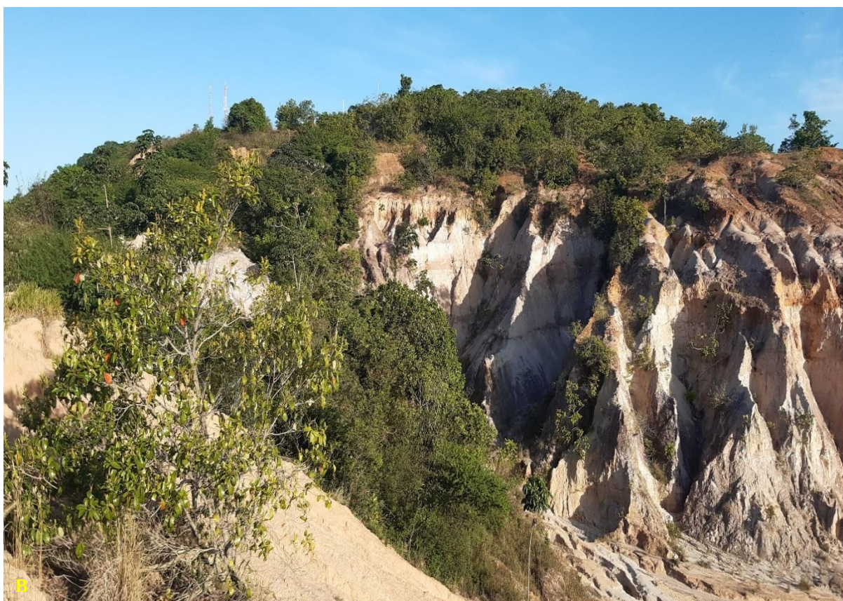
Figura 65: A e B – Formação de ravinas e microrravinas denunciando processo erosivo mais crítico do estágio 2 com tendência ao voçorocamento em encostas de topo convexo no bordo oeste do Morro do Urubu, Bairro Porto Dantas. Predomínio das cores vermelho-amarelada devido à presença de óxido de ferro, silício e alumínio.
