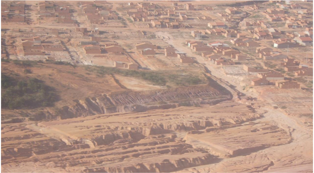
Figura 81: Imagem aérea evidenciando processo erosivo acelerado em área de intervenção pública estadual para ampliação da pista do aeroporto no Bairro Santa Maria.
