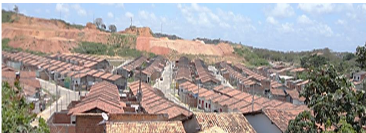
Figuras 83: Intervenção do Estado no desmorte de morros para construção de habitações populares na Comunidade Coqueiral, Av. Gen. Euclides Figueiredo, Bairro Porto Dantas.
