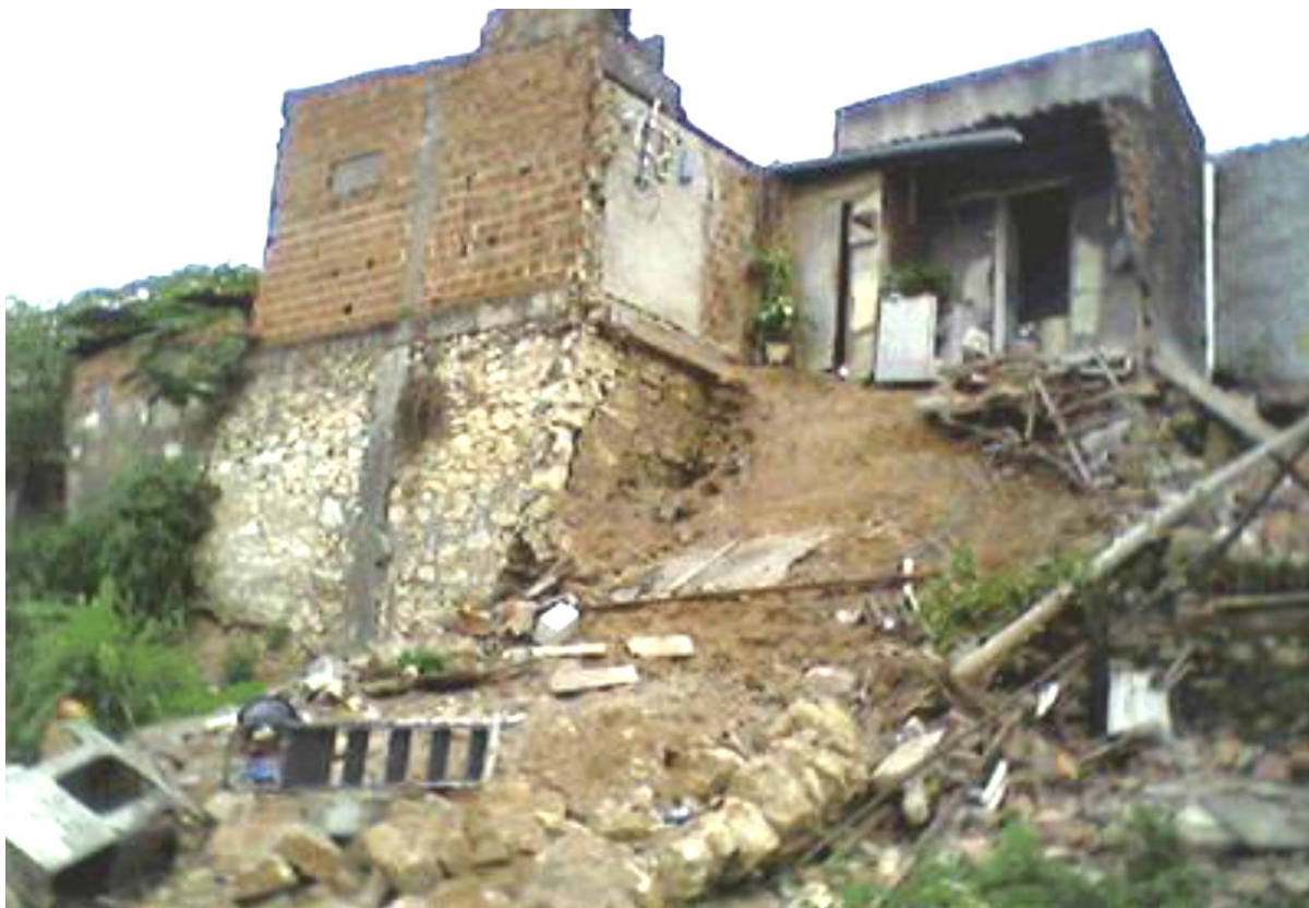
Figura 77: Escorregamento de terra translacional em período chuvoso no Alto da Jaqueira, Bairro Cidade Nova. Fonte: Defesa Civil, 2013.
