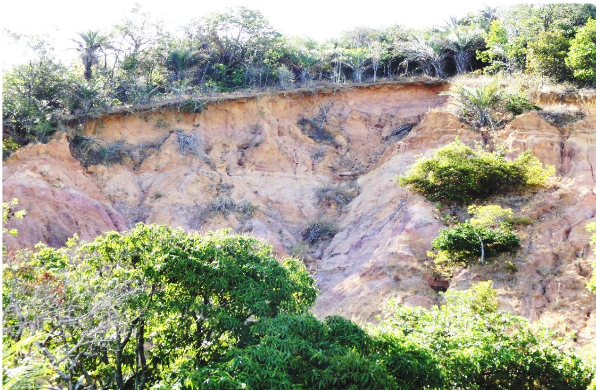
Figura 73: Sulcos e Ravinas no interior de voçoroca originada após movimento gravitacional de massa associado aos escorregamentos translacionais indicando rotas de organização do escoamento superficial concentrado, no bordo leste do Morro do Urubu, Bairro Porto Dantas.
