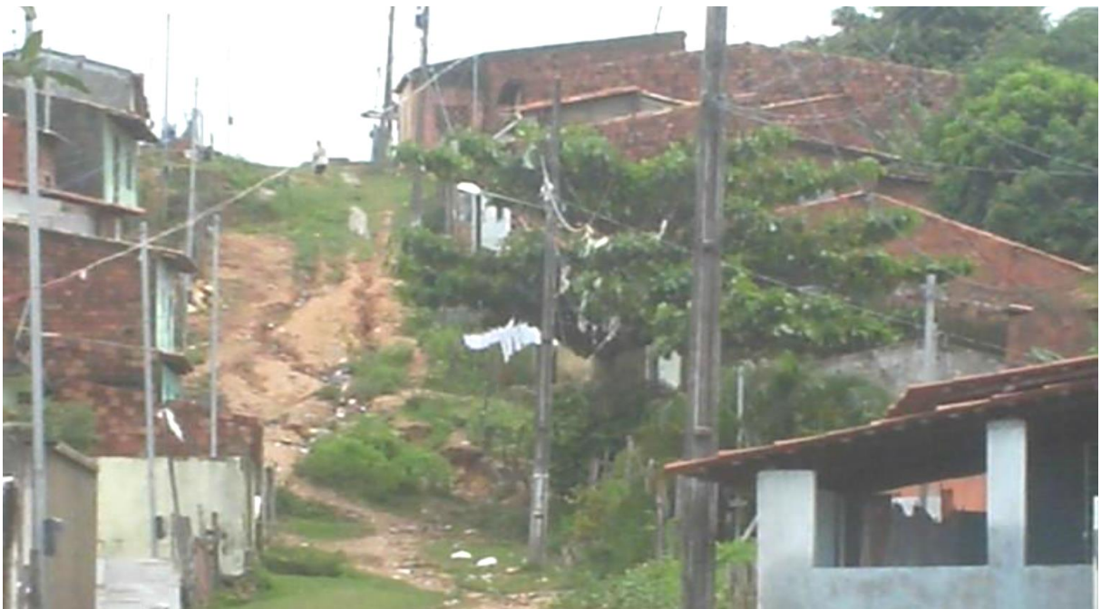
Figura 82: Ocupação irregular no terço médio e inferior da encosta e processo de ravinamento associado ao escoamento superficial concentrado no Bairro Porto Dantas.
