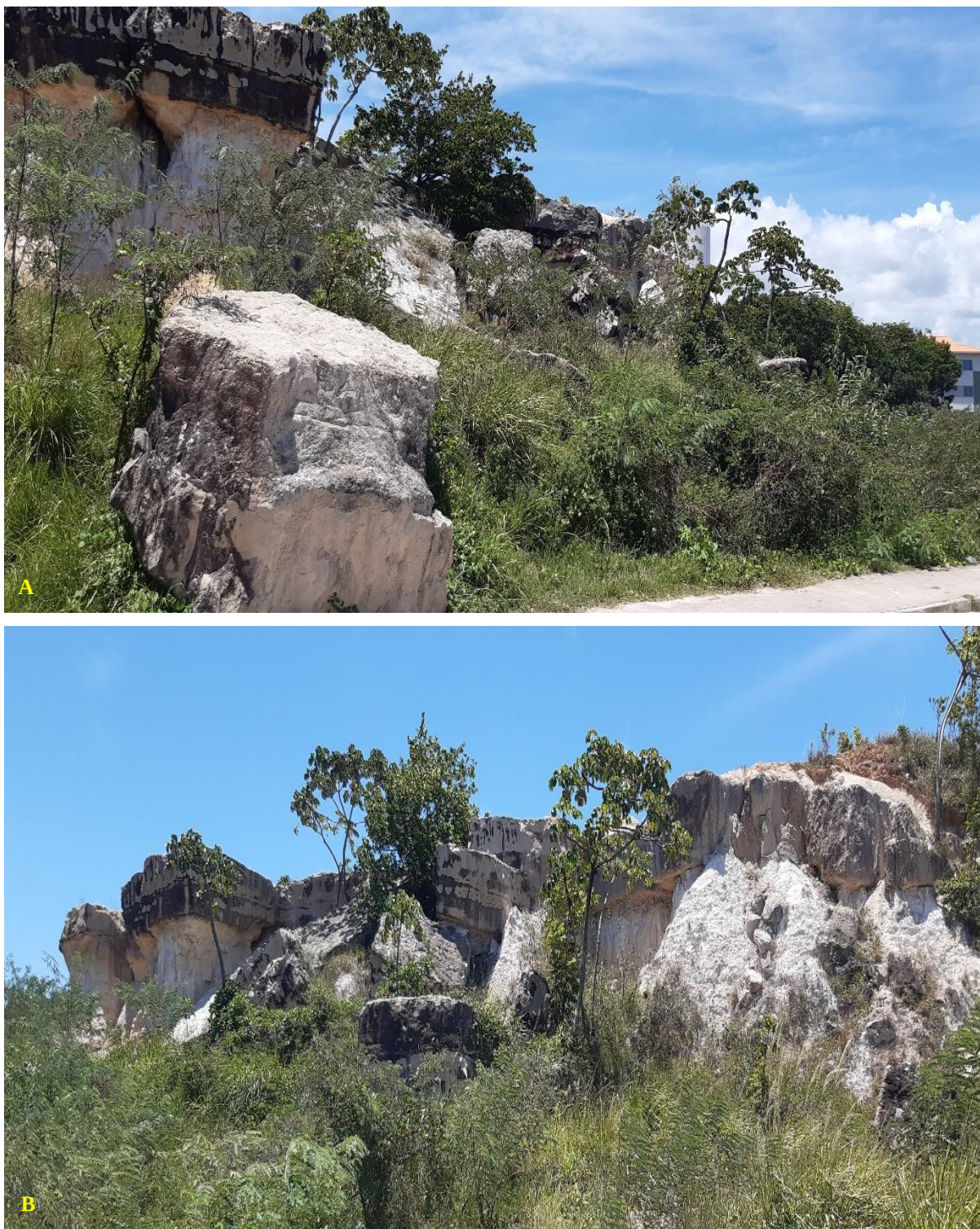
Figura 80: A e B – Queda de blocos de arenito depositados nos terços médio e inferior de encosta intemperizada com pouca participação da cobertura vegetal. Rua São Francisco, Bairro Cidade Nova.
