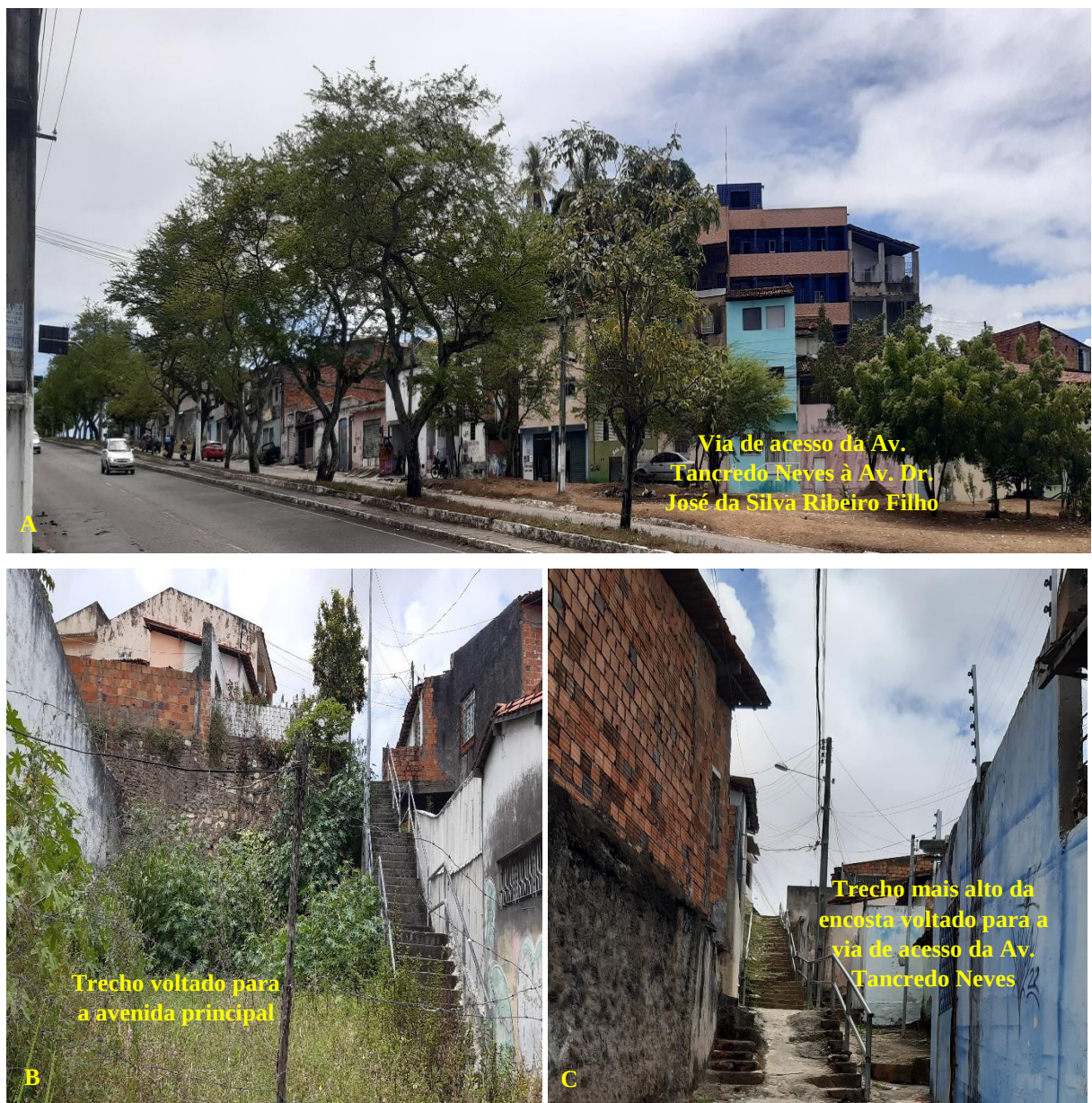
Figura 92: A – Encosta da Av. Dr. José da Silva Ribeiro Filho, posicionada no sentido centro de Aracaju. No limite da encosta tem-se os quintais das residências construídas na base, algumas delas verticalizadas. Observa-se em B e C escadas de acesso para facilitar o deslocamento da população residente no terço superior.
