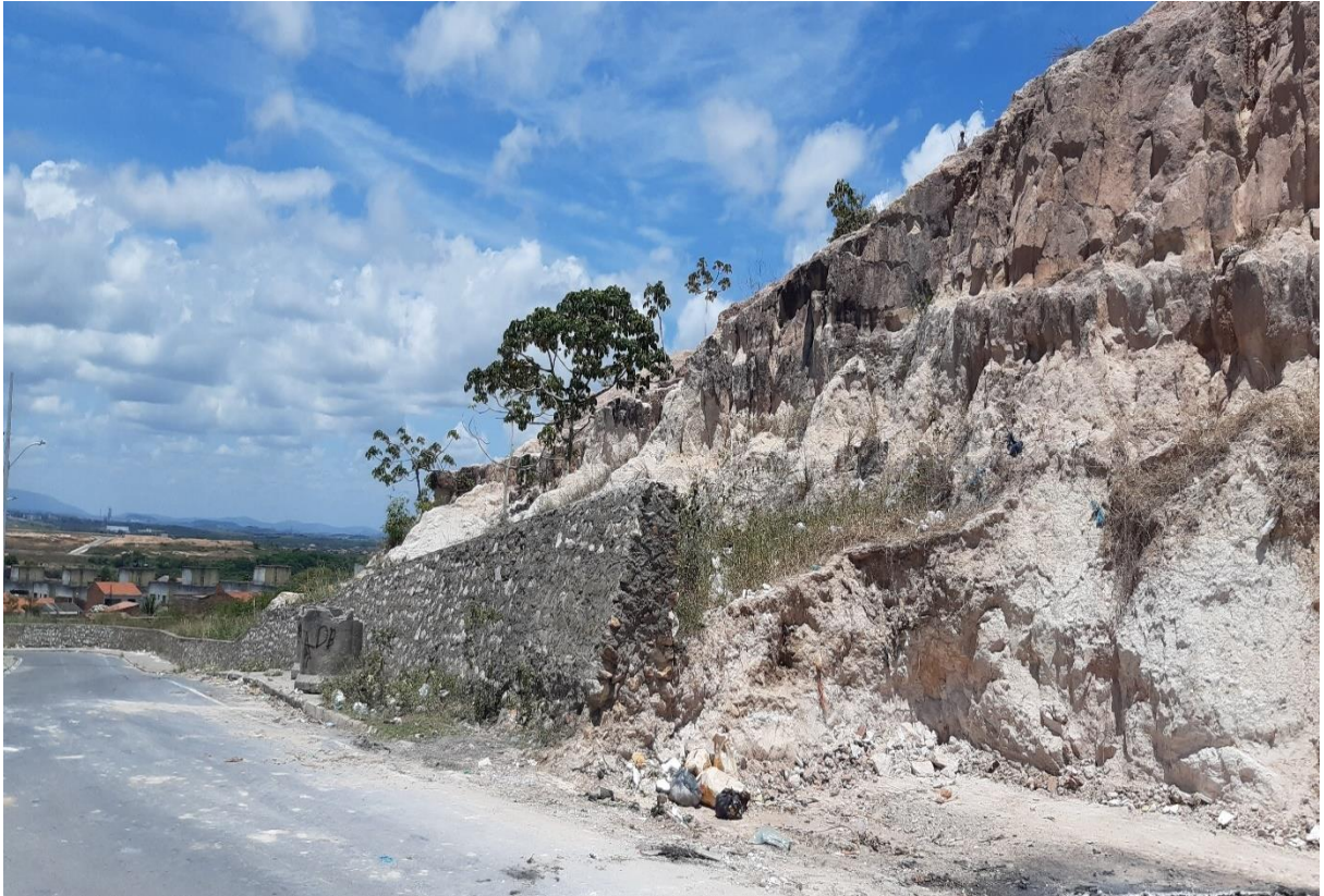
Figura 95: Muro de arrimo como obra de contenção aos escorregamentos translacionais em encosta de morro na rua D do Bairro Cidade Nova.
