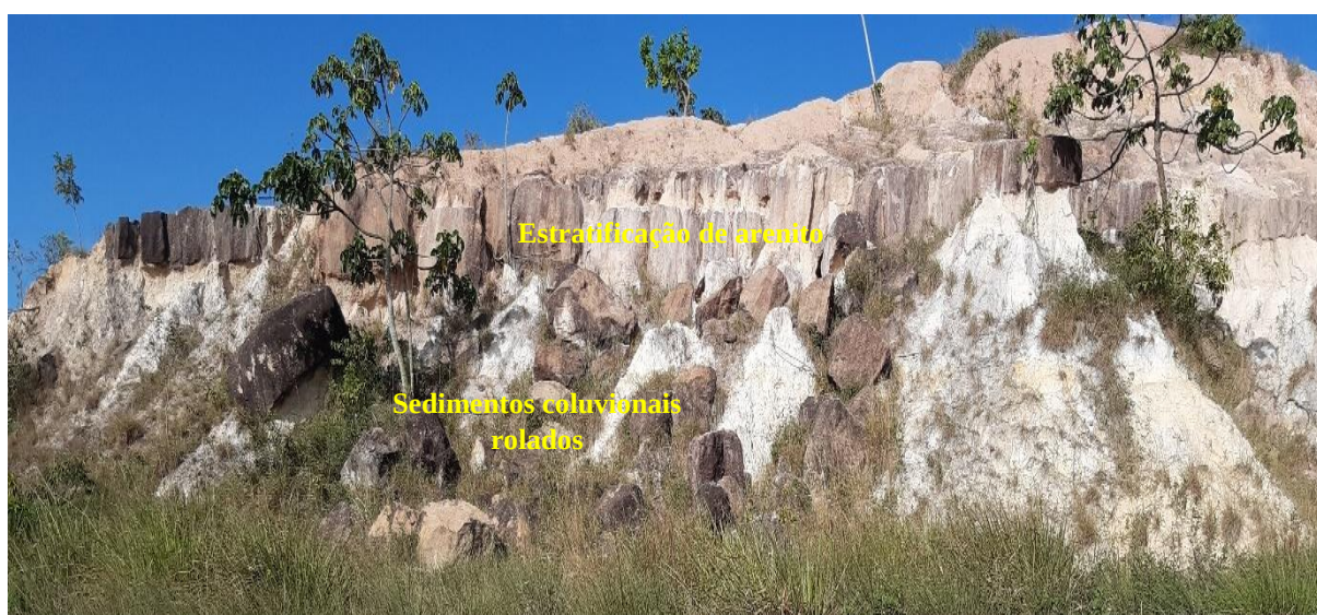
Figura 79: Queda de blocos de arenitos depositados nos terços médio e inferior de encosta ravinada na rua D do Bairro Cidade Nova.
