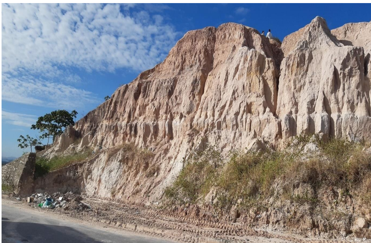
Figura 62: Efeitos do escoamento superficial concentrado evidenciando processo inicial de ravinamento (estágio 1) em encosta íngreme da rua D, Bairro Cidade Nova.
