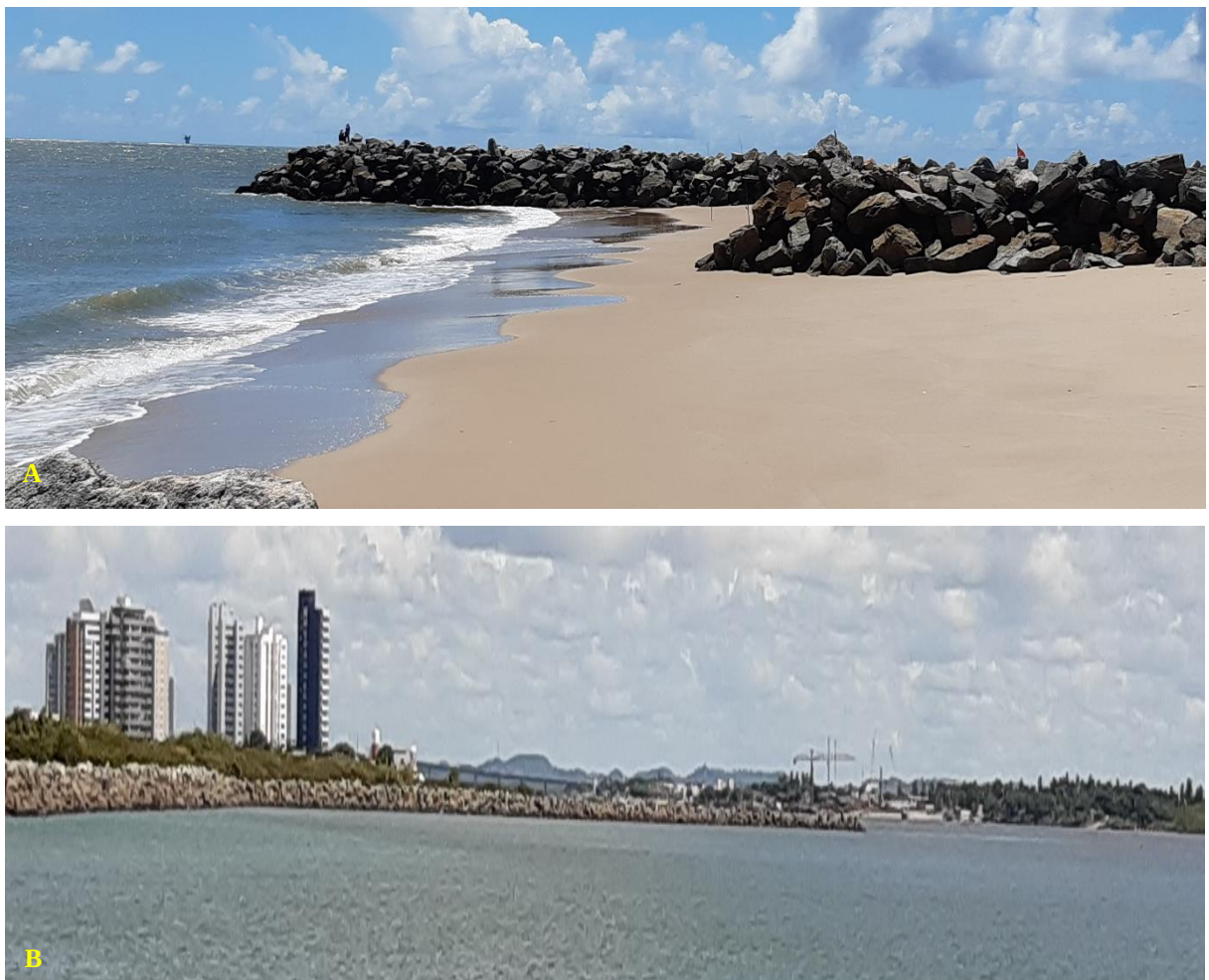
Figura 39 A e B: Obras contensivas para amenização do processo erosivo severo na margem direita do rio Sergipe até as imediações do pontal arenoso, Bairro Coroa do Meio.
