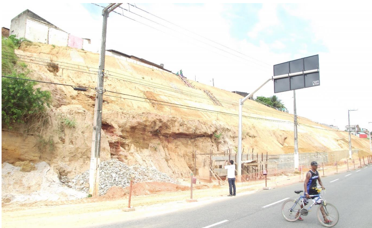
Figura 90: A – Obras de contenção da encosta na Av. Dr. José da Silva Ribeiro Filho, no Bairro América. Créditos: Givaldo dos Santos Bezerra e Hélio Mário de Araújo, 2012.
