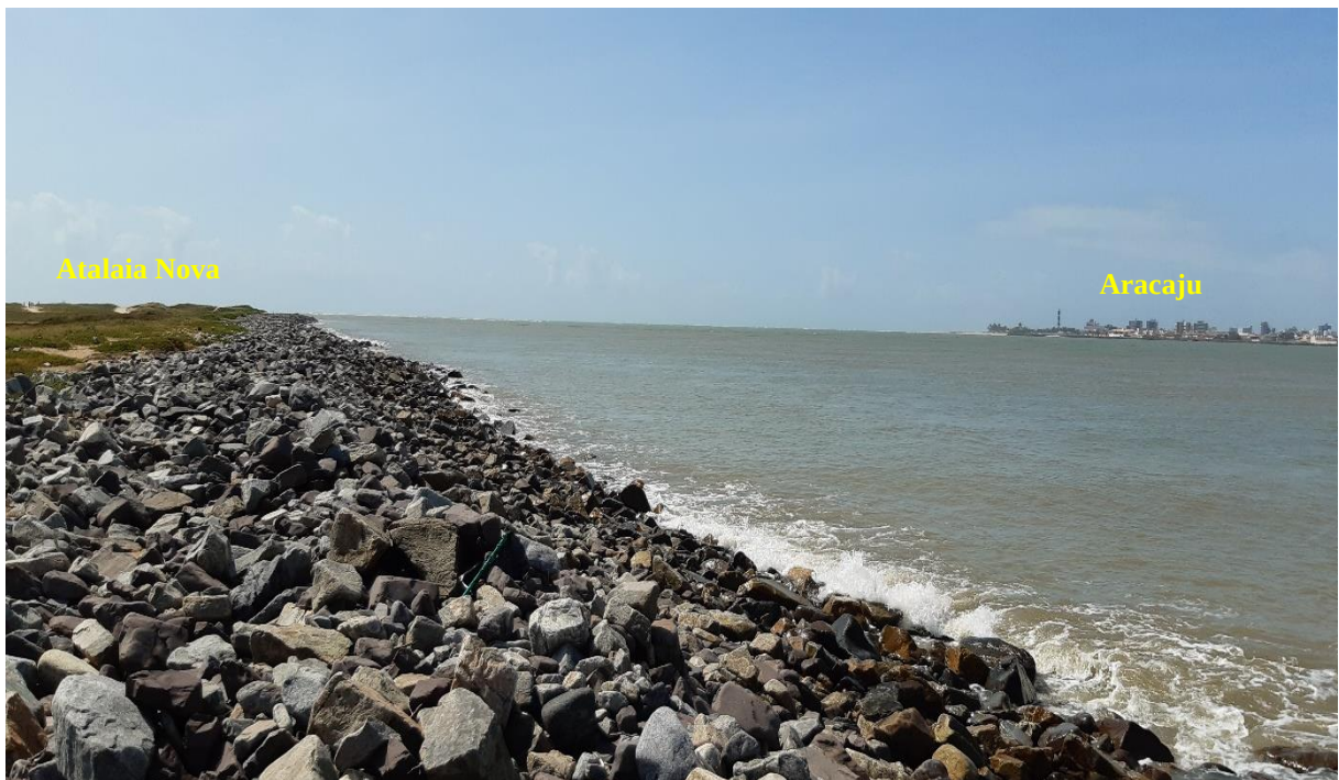
Figura 36: Molhe construído na margem esquerda do rio Sergipe para conter o processo erosivo, Barra dos Coqueiros.
