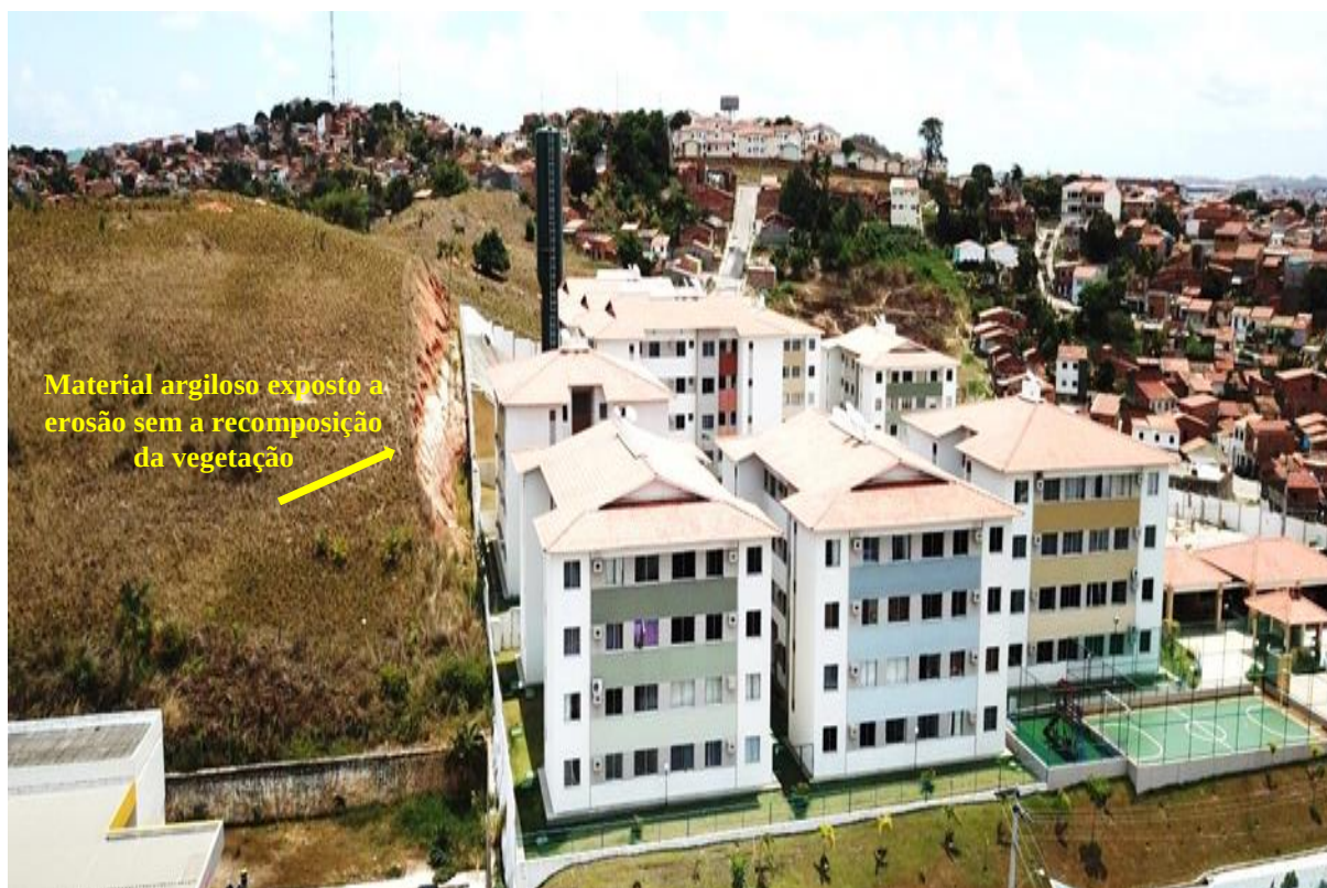
Figura 25: Desmorte de morro de topo arredondado para construção de condomínio fechado no Bairro Japaozinho, zona norte de Aracaju.
