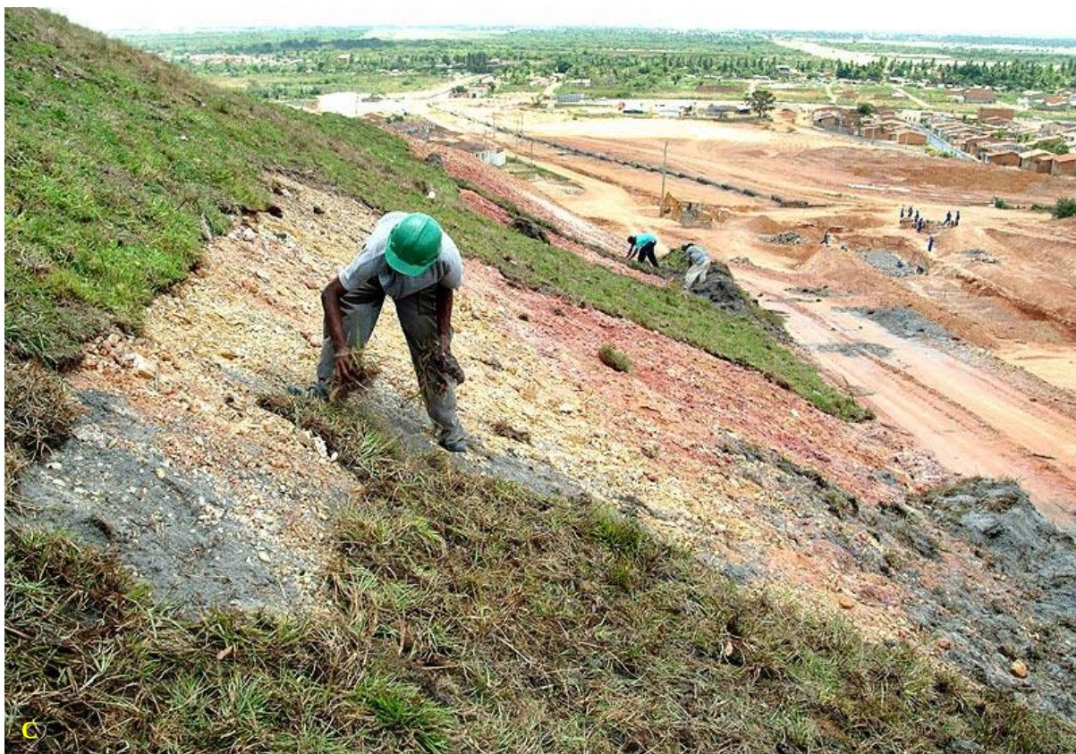
Figura 89: C -Plantio de gramado para conter a erosão no topo e encostas do Morro do Avião, Bairro Santa Maria. Crédito: Site oficial da Prefeitura Municipal de Aracaju, 2005. Publicado em 27 de dezembro de 2005 pelo Instituto Marcelo Déda – IMD.
