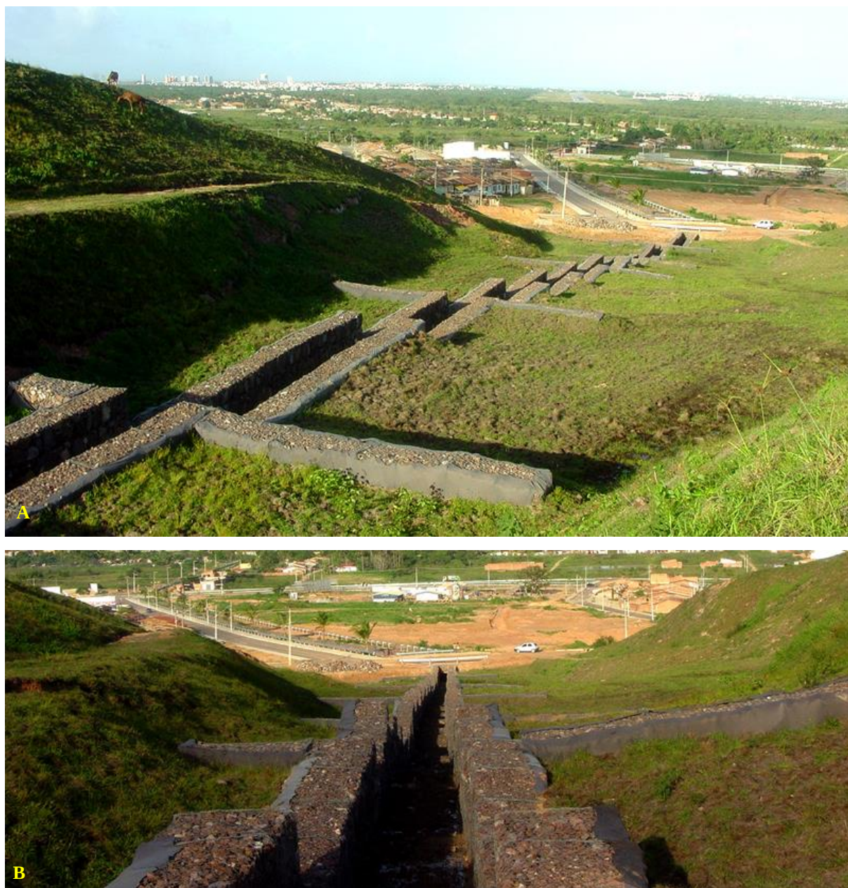
Figura 88: A e B - Obra de contenção do Morro do Avião no Bairro Santa Maria.
