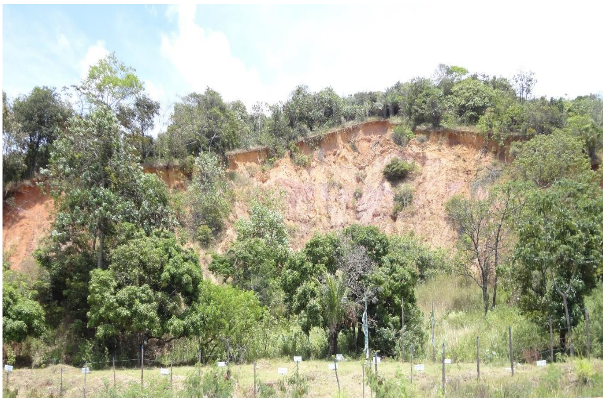
Figura 61: Evolução do escoamento superficial pela concentração do fluxo de água no interior de voçoroca originada após movimento gravitacional de massa associado aos escorregamentos translacionais (estágio 2) no bordo leste do Morro do Urubu, Bairro Porto Dantas.
