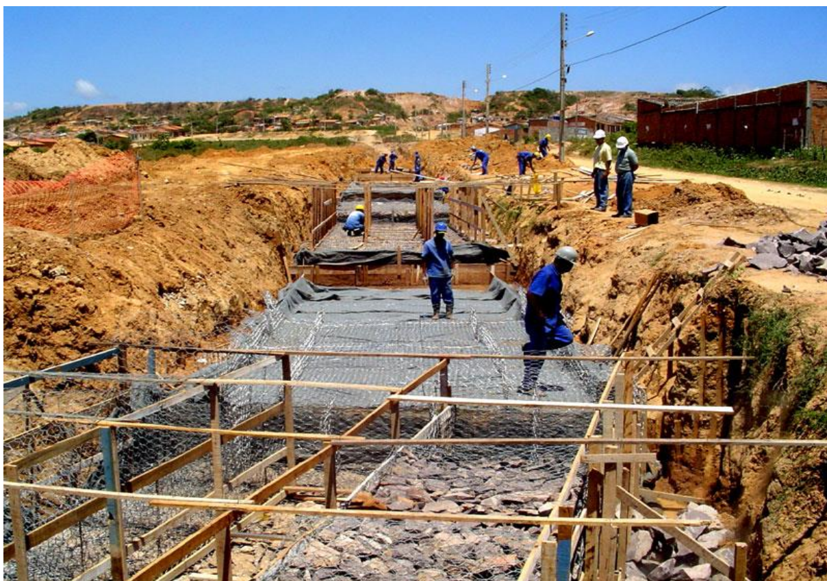
Figura 87: Implantação de infraestrutura para o controle da erosão no Morro do Avião, Bairro Santa Maria. Crédito: Site oficial da Prefeitura Municipal de Aracaju, 2006.
