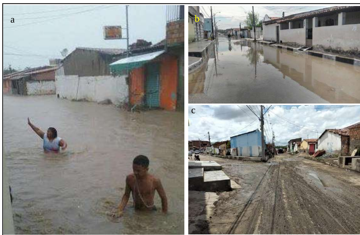
Figura 79 - Inundação e alagamento no bairro Baraúnas em Feira de Santana - BA
