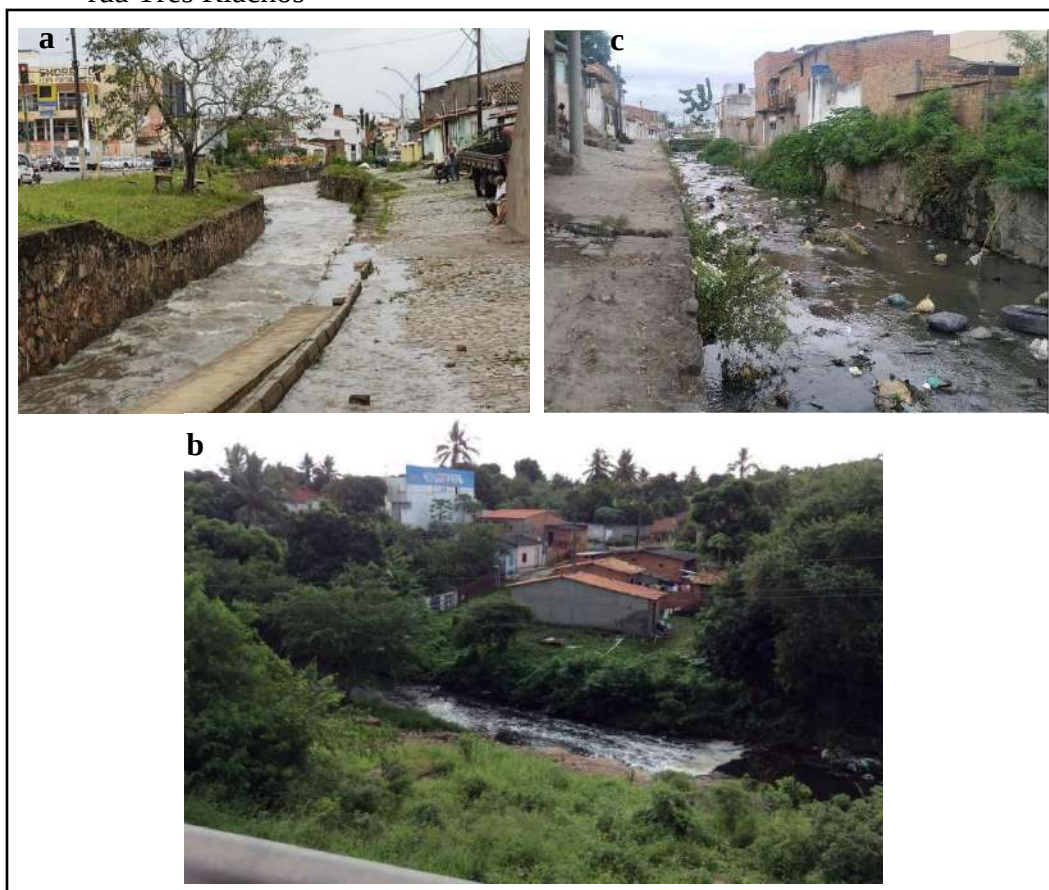
(a) – Trecho da Avenida de Canal, próximo ao bairro Rua Nova; (b) – Trecho na rua Três Riachos no bairro Pedra do Descanso. Imagens tiradas por Laerte Dias em Junho de 2021 e Janeiro de 2020. (c) Trecho da Avenida de Canal, próximo ao bairro Rua Nova. Imagem retirada do PMAUFS, 2020
