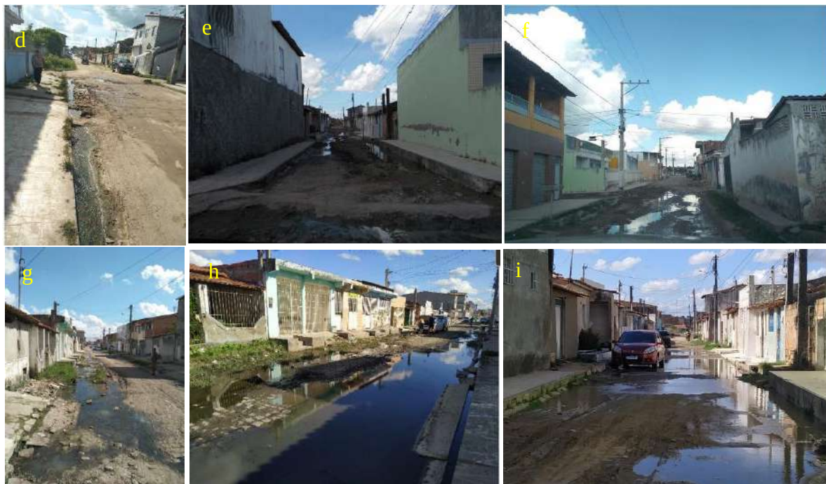
Figura 65 - Esgoto a céu aberto e valas de escoamento pluvial improvisada no bairro Estação Nova (Lagoa Grande) em Feira de Santana - BA
