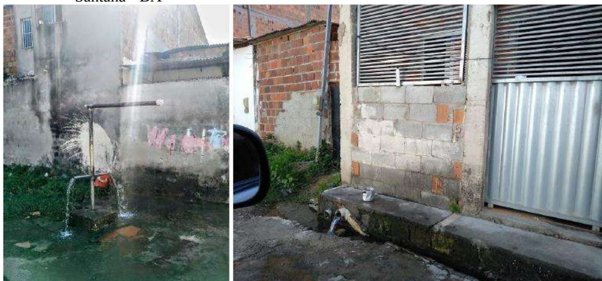
Figura 66 - Nascente sob as construções no bairro Estação Nova (Lagoa Grande) em Feira de Santana - BA
