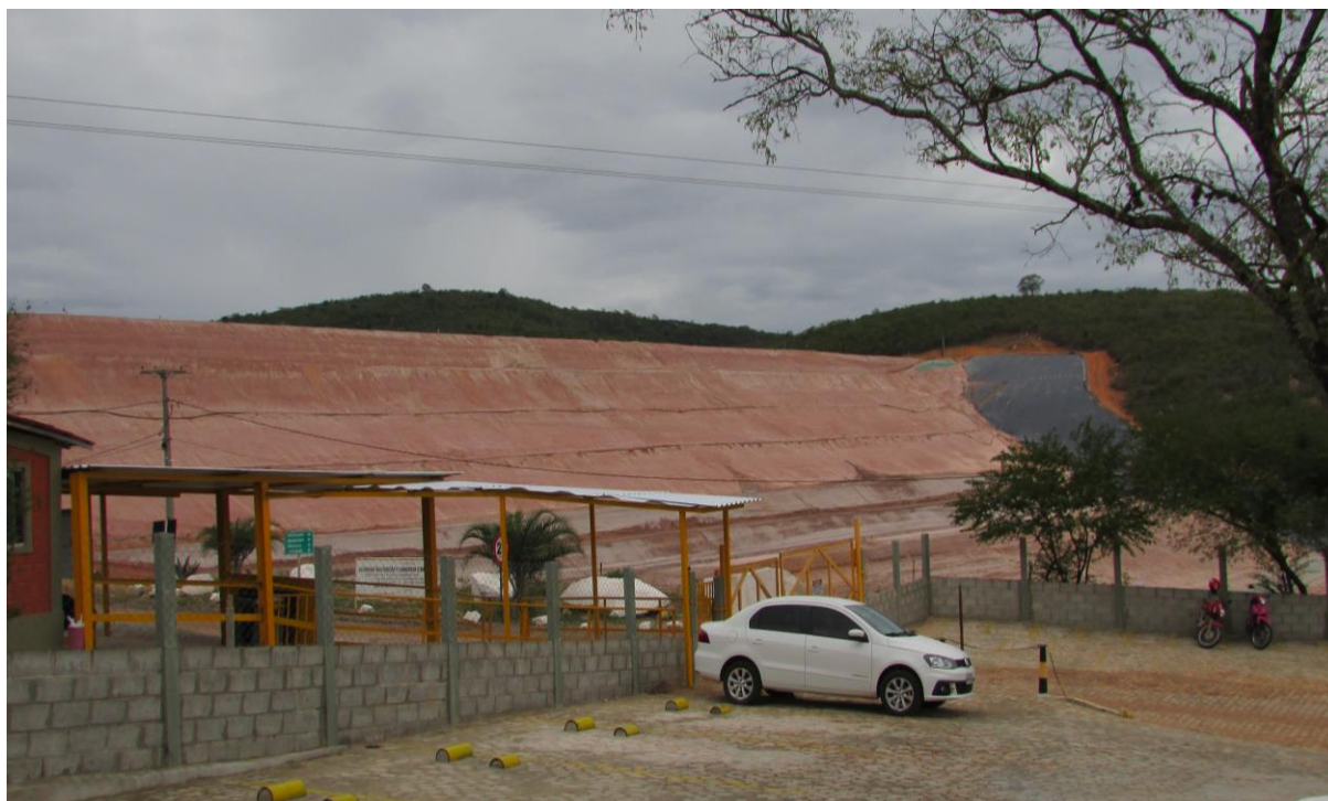
Figura 71: Vista panorâmica da barragem 02, ativa, da Yamana Gold. Crédito: Bismarque Lopes Pinto, 2020.
