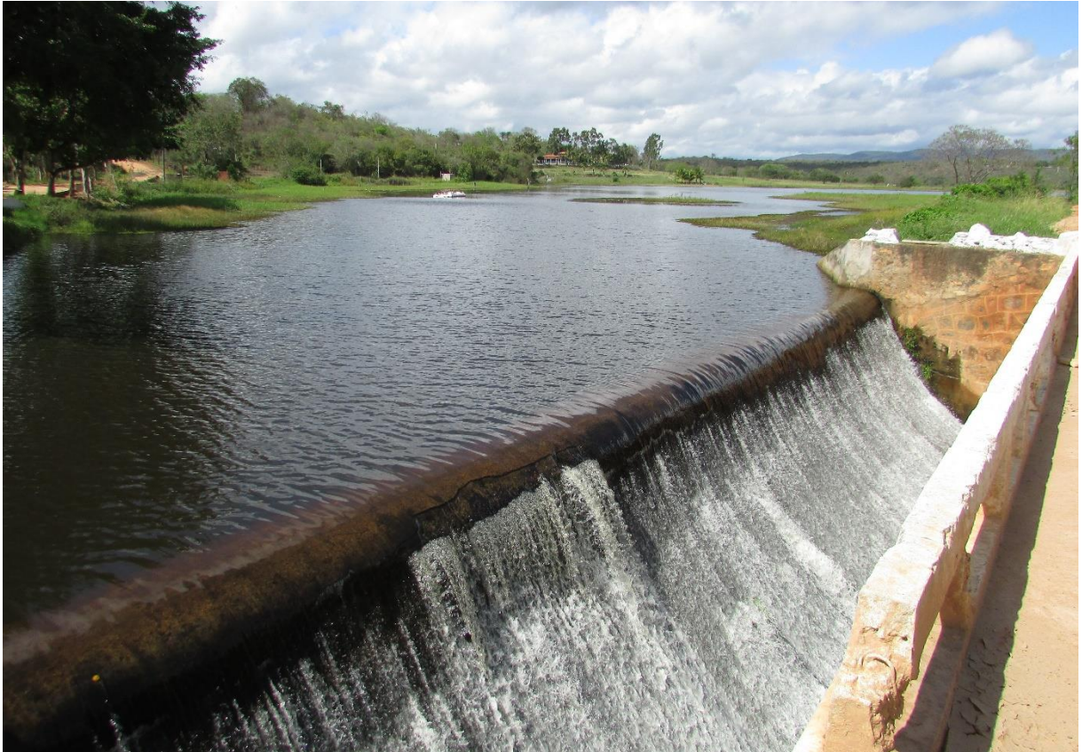
Figura 29: Barragem construída no médio curso do rio Sapucaia. Crédito: Bismarque Lopes Pinto, 2022.
