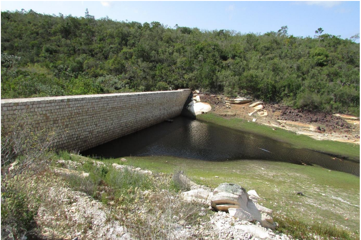
Figura 24: Barragem no rio Caatinga do Moura, construída sobre vale de fundo plano, apresentando indícios de extração mineral nas margens do canal fluvial. Crédito: Bismarque Lopes Pinto, 2021.
