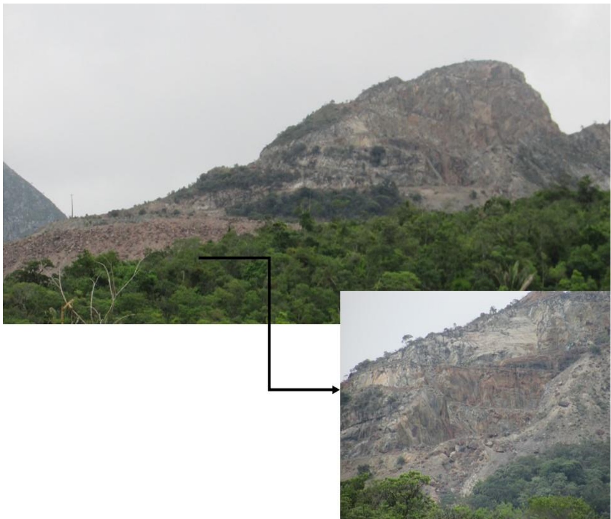
Figura 50: Desmonte da vertente oeste da Serra do João Belo, por sequenciais processos erosivos causados pela mineração, Jacobina/BA.
