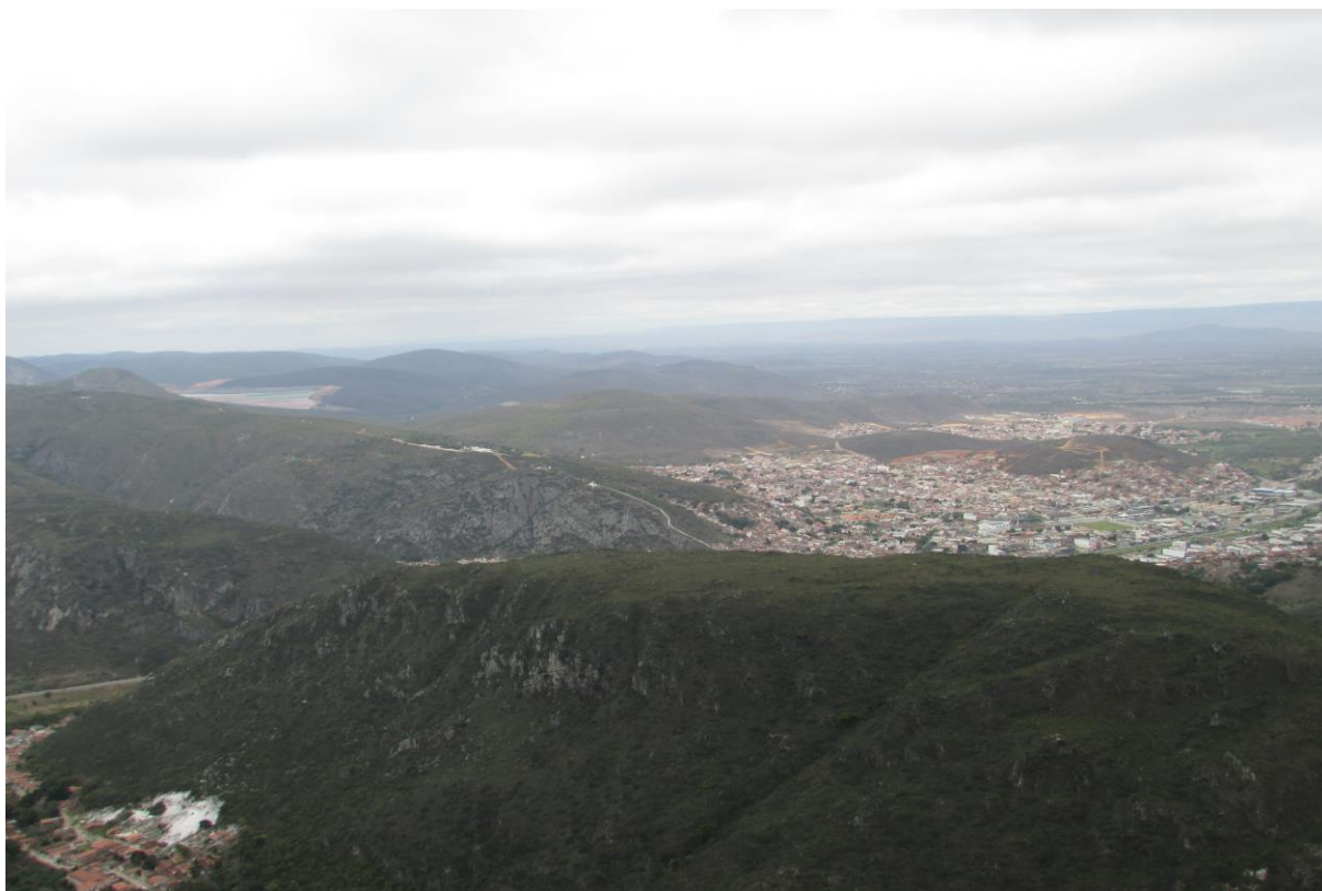
Figura 05: Barragem de rejeitos da empresa Yamana Gold, ao sul da área urbana de Jacobina. Crédito: Bismarque Lopes Pinto, 2021.
