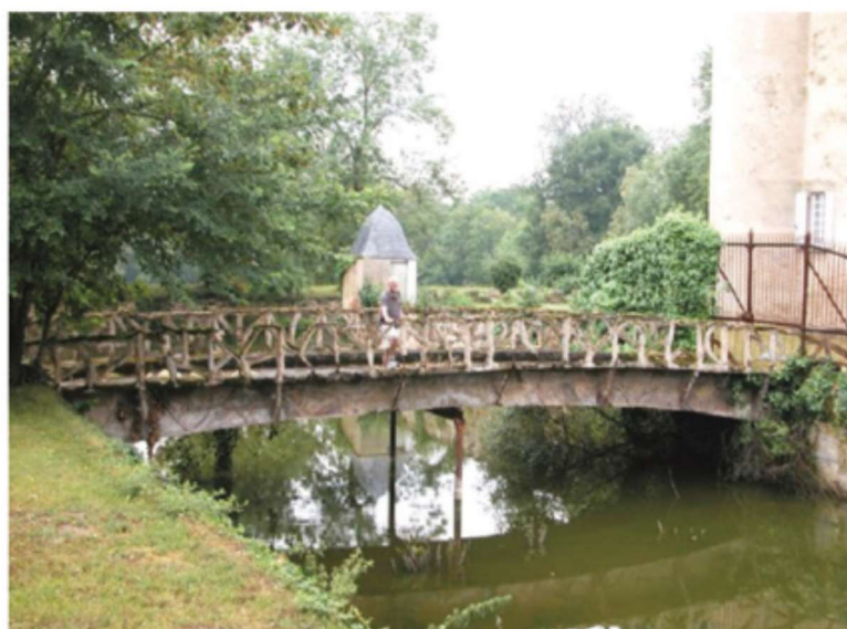
Figura 1- Ponte de concreto armado projetada e construída por Monier, em 1875 [2].
