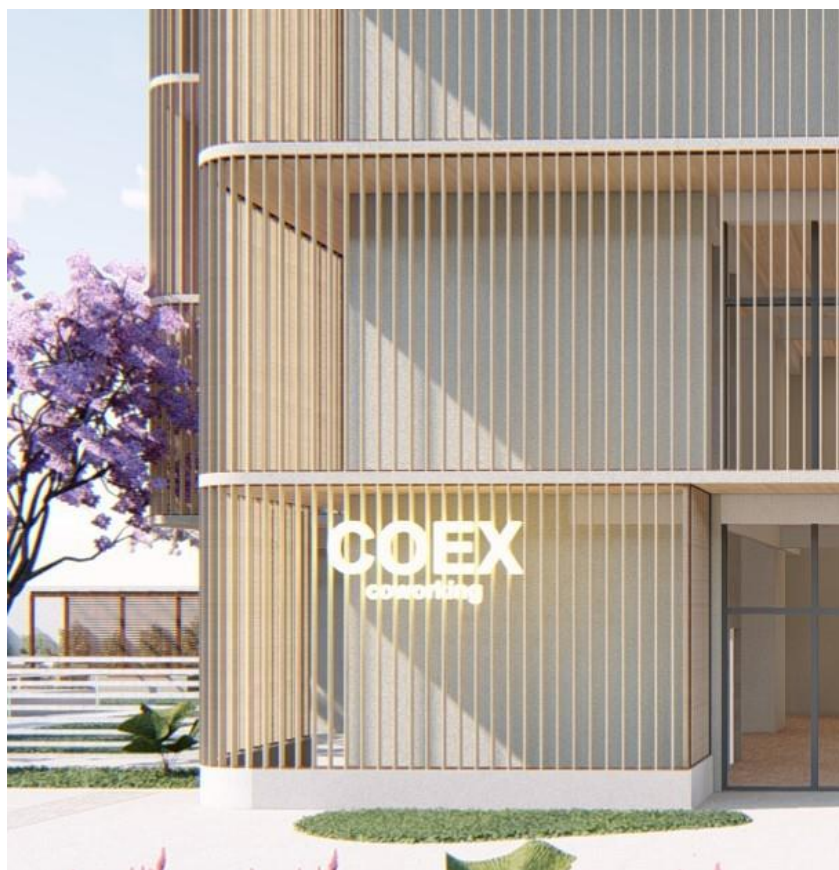
Figura 49 – Prolongamento da laje e painel de madeira para proteção da fachada
