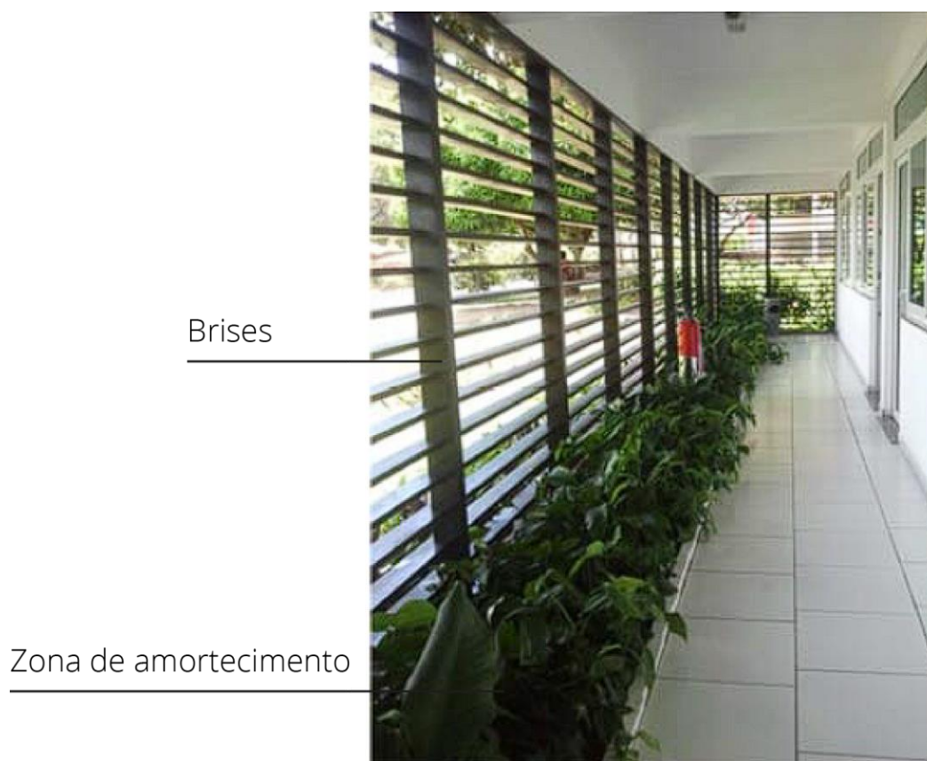
Figura 22 – Vista da circulação interna – Zona de amortecimento.
