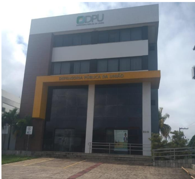
FIGURA 3: Sede da DPU-SE em 2022.
