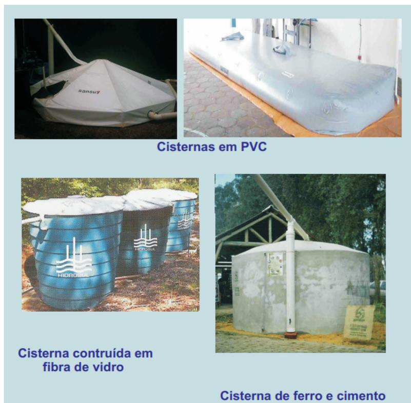
Figura 6.3: Tipos de cisternas (Fonte: EMBRAPA)Tipos de cisternas (Fonte: EMBRAPA)
