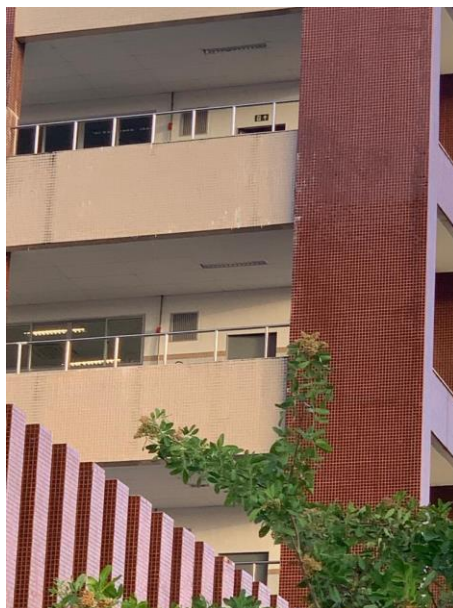
Figura 49 - Sinalização de orientação e salvamento indicando escada
