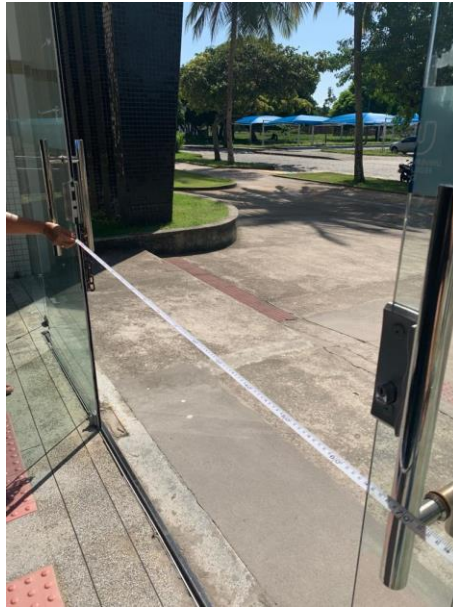
Figura 39 - Saída de emergência aberta
