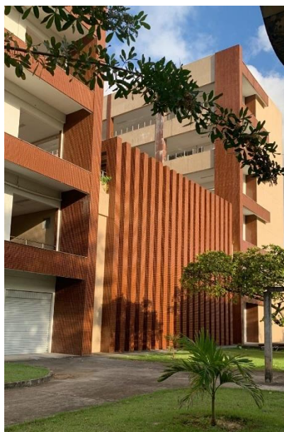
Figura 35 - Fachada transversal oposta a principal
