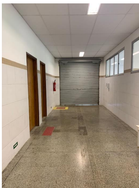
Figura 48 - Saída de emergência
