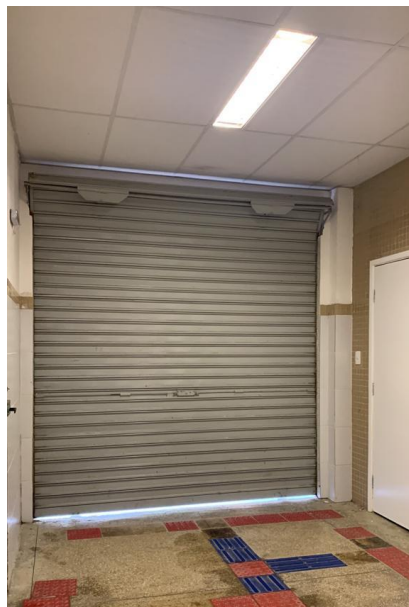
Figura 40 - Saída com porta metálica
