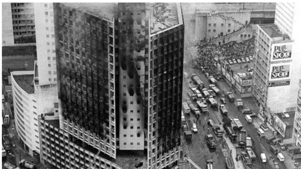
Figura 1 - Edifício Joelma logo após o controle das chamas
