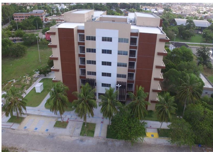
Figura 32 - Fachada da entrada principal
