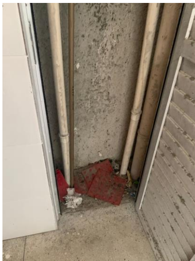
Figura 34 - Shaft 4 próximos aos elevadores, 4º pavimento
