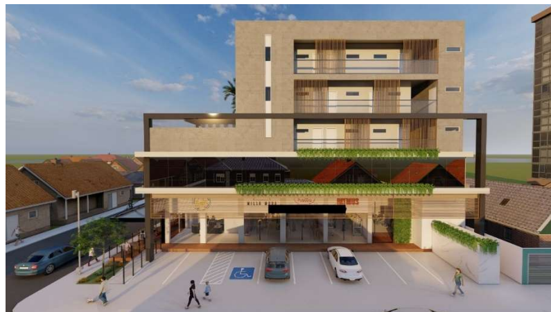
Figura 6 – Fachada lateral do edifício de estudo.
