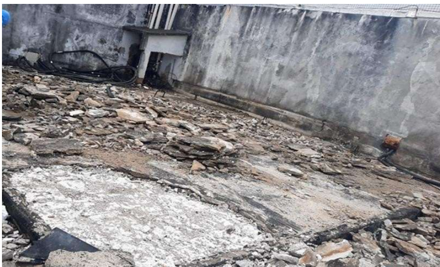
Figura 18 – Execução da demolição da proteção mecânica e remoção da manta asfáltica existente
