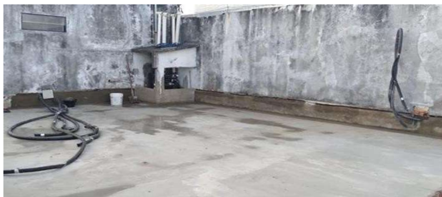
Figura 20 – Depois da demolição da proteção mecânica e remoção da manta asfáltica existente
